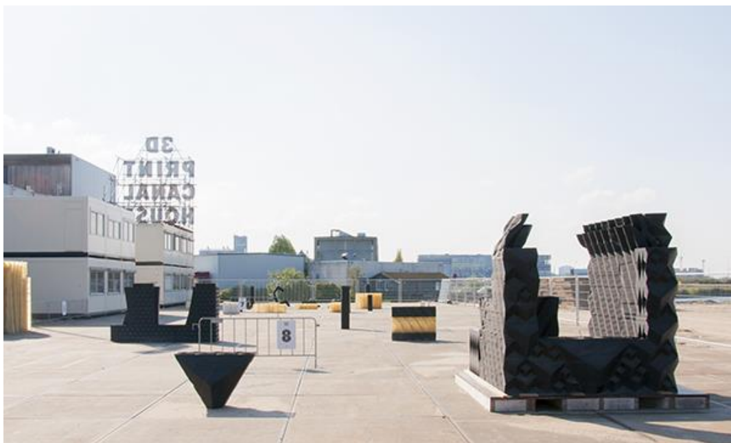
Obr. 7 Rozestavěný domek (v pravé části obrázku) v rámci projektu 3DPRINTCANALHOUSE od DUS Architects [9]
