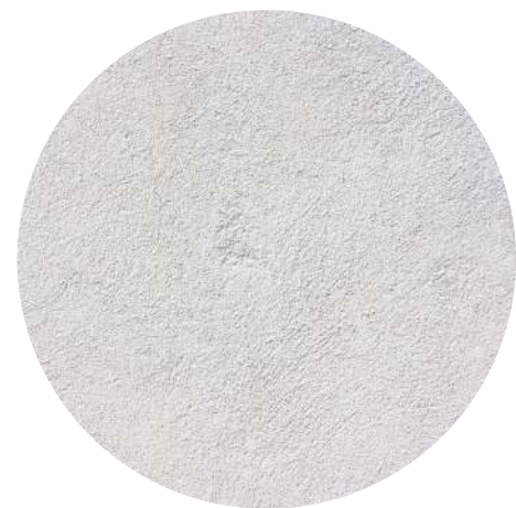
OMÍTKA S BÍLÝM NÁTĚREM
