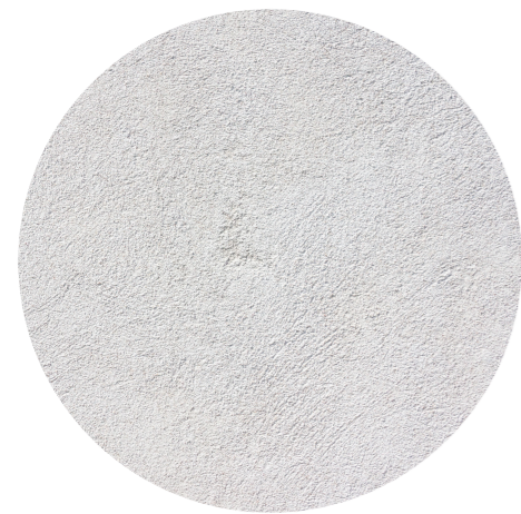
OMÍTKA S BÍLÝM NÁTĚREM
