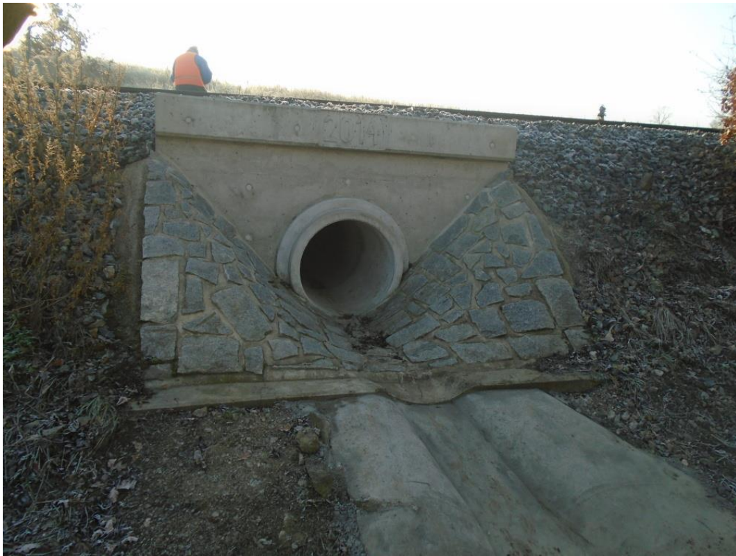
Obrázek 32: Propustek trubní na trati č. 172
