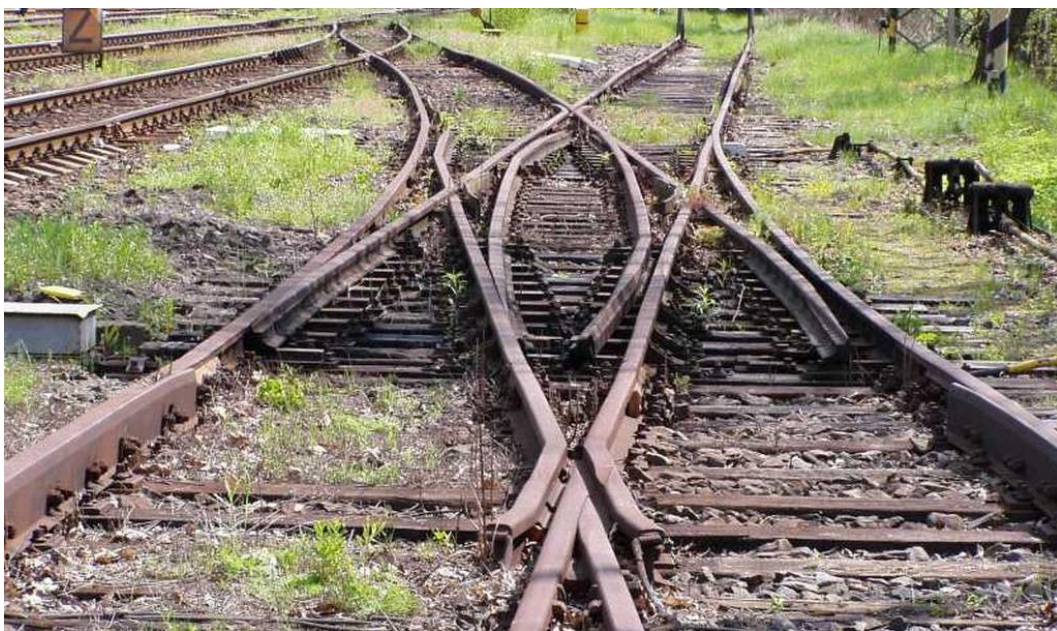
Obrázek 15: Výhybková křižovatka [24]
