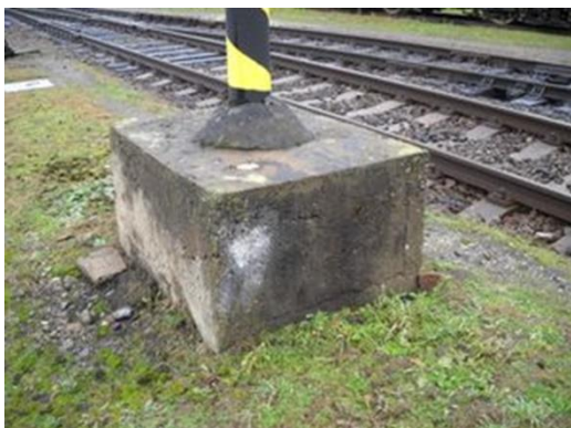
Obrázek 27: Sokl trakční podpěry ocelové trubkové [24]
