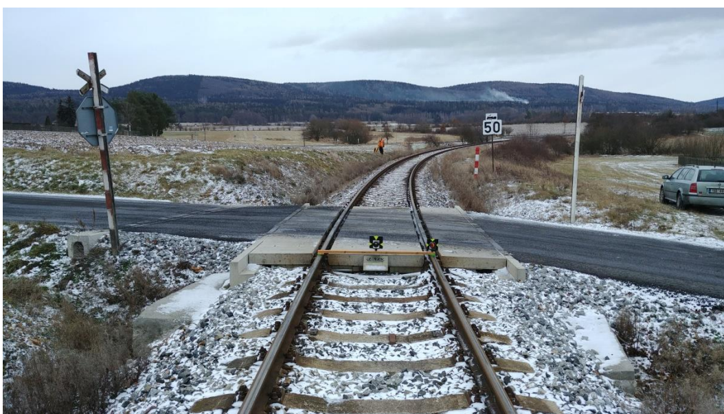
Obrázek 55: Přejezd P584 na km 13,243 trati č. 172
