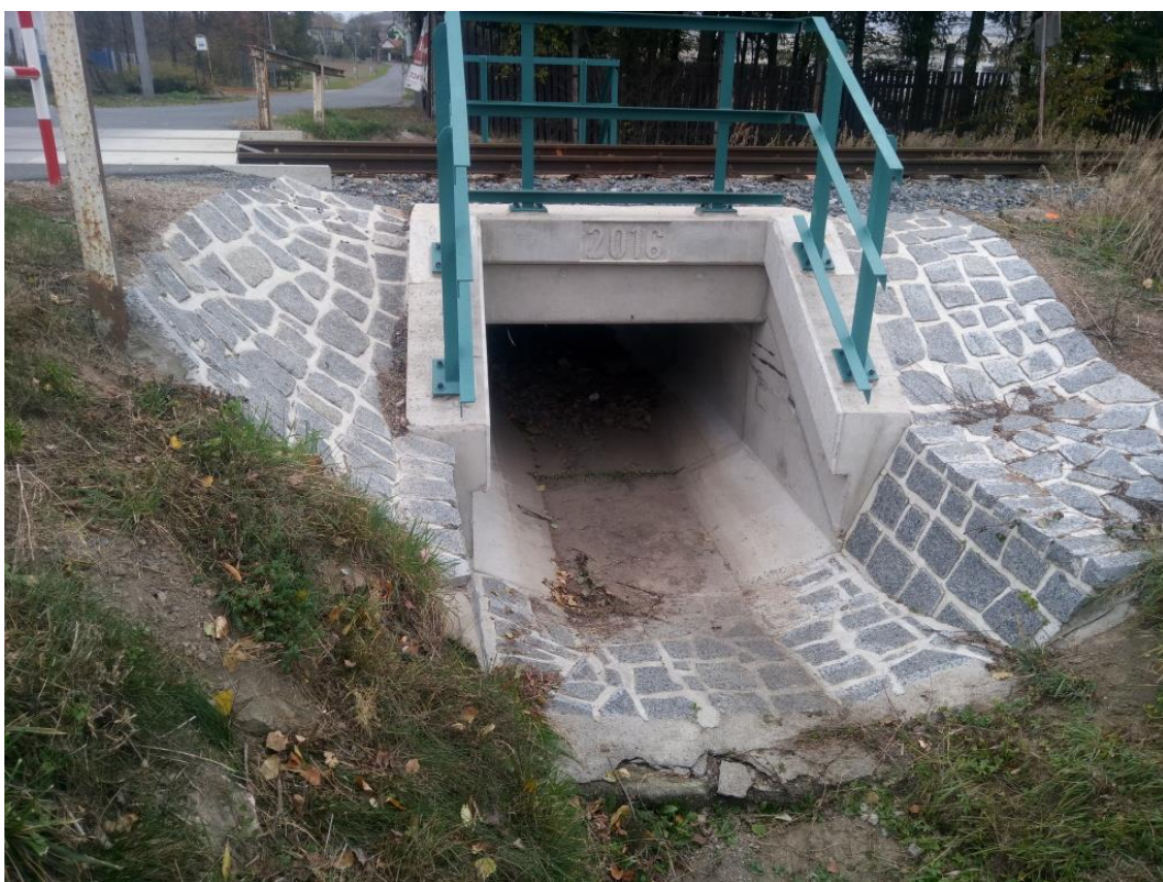
Obrázek 33: Propustek mimotrubní na trati č. 172
