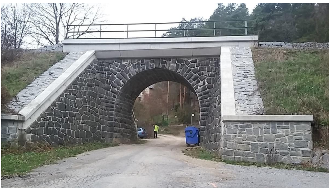
Obrázek 31: Železniční most na trati č. 172
