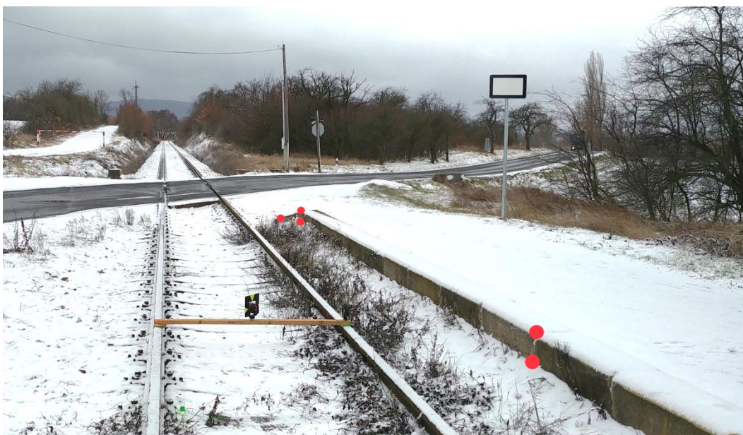
Obrázek 37: Úrovně obrubníkové nástupiště s vyznačenými měřenými body
