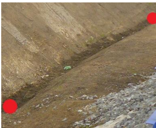
Obrázek 29: Příkop s nezpevněným dnem [24]
