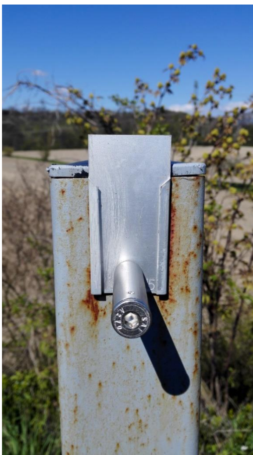
Obrázek 4: Konzolová zajišťovací značka [17]
