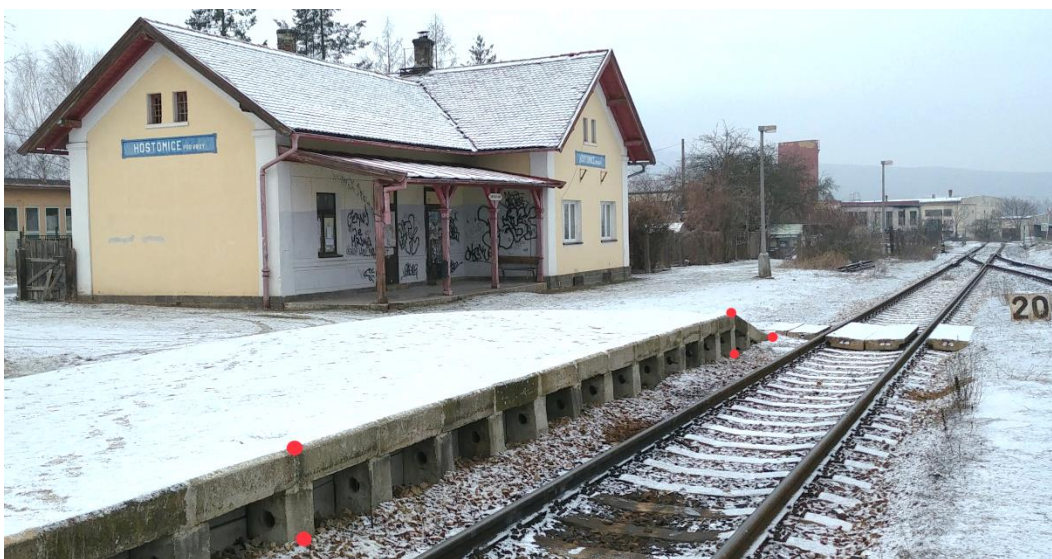
Obrázek 36: Mimoúrovňové nástupiště s vyznačenými měřenými body
