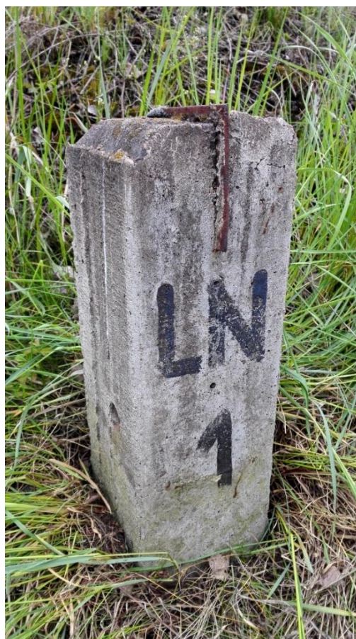
Obrázek 5: Sloupkový typ zajišťovací značky [17]
