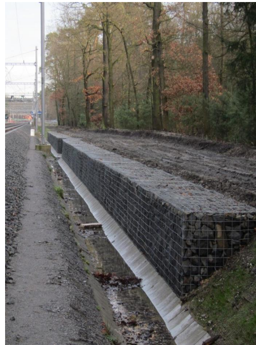
Obrázek 35: Malá gabionová zárubní zeď [24]
