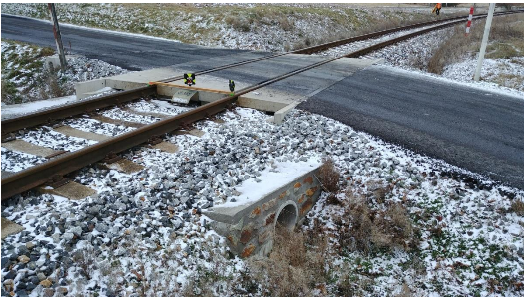
Obrázek 2: Propustek u přejezdu přes trať č. 172
