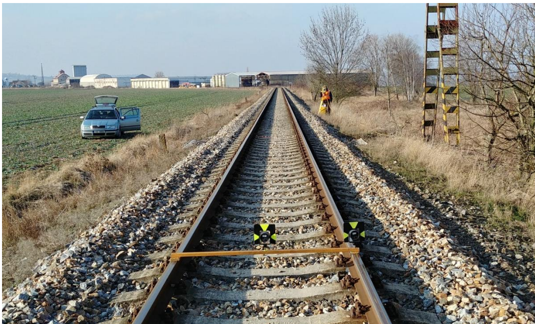
Obrázek 9: Zaměření osy koleje na rozchodku
