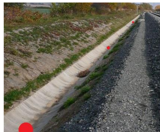
Obrázek 30: Příkop se zpevněným dnem (žlab) [24]
