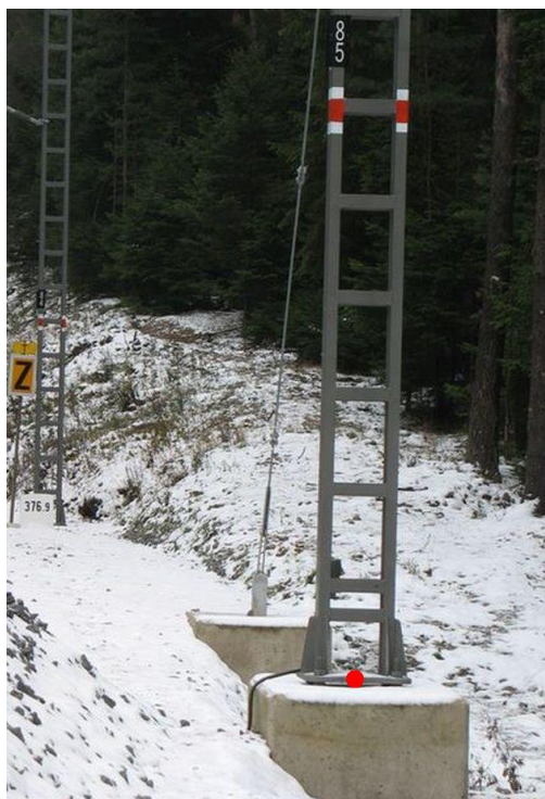
Obrázek 18: Trakční podpěra ocelová jednoduchý profil [24]
