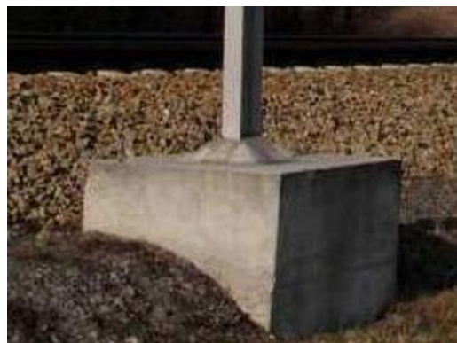
Obrázek 28: Sokl kotvy trakční podpěry [24]
