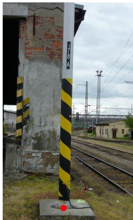
Obrázek 19: Trakční podpěra ocelová trubková [24]
