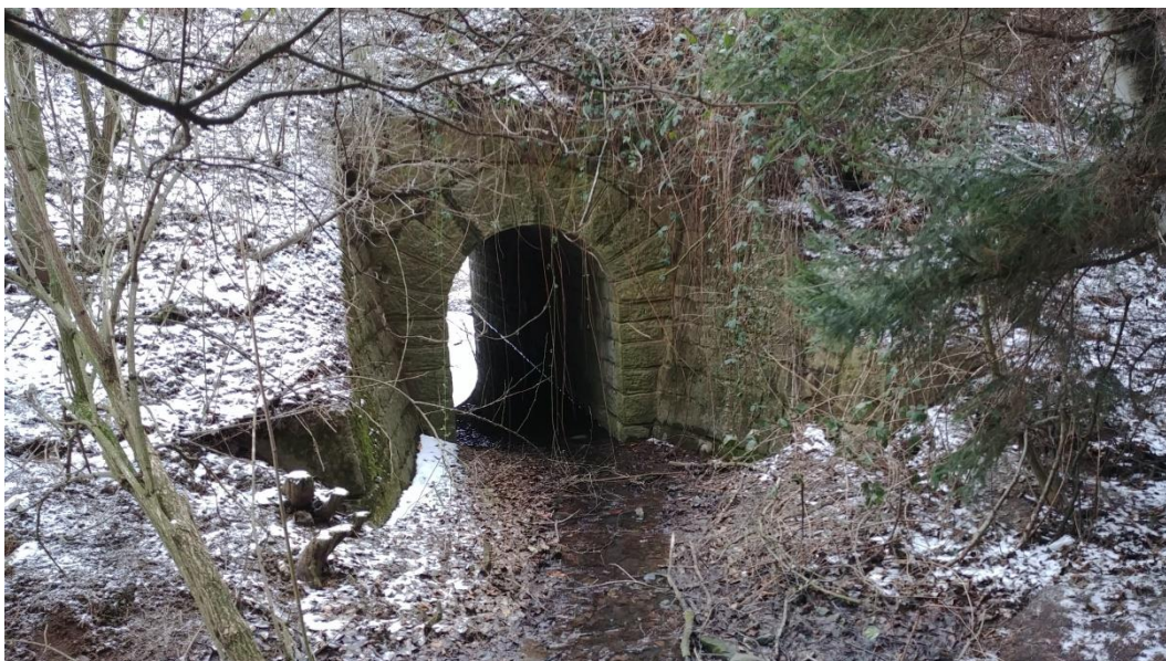
Obrázek 50: Propustek mimotrubní na km 15,118 trati č. 172
