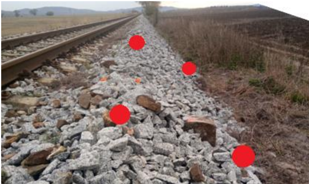
Obrázek 23: Vyznačené hrany štěrkového lože
