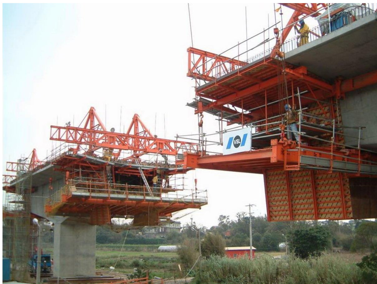
Obr. 16 Provádění letmé betonáže [14]
