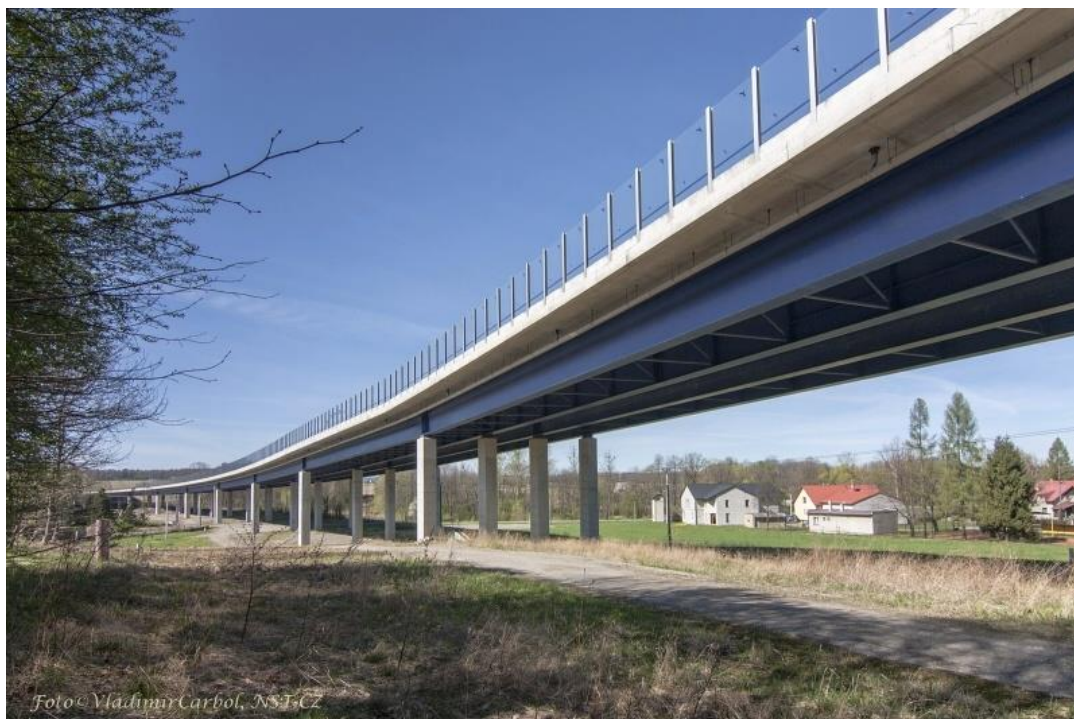
Obr. 9 Pohled na most přes údolí Stonávky
