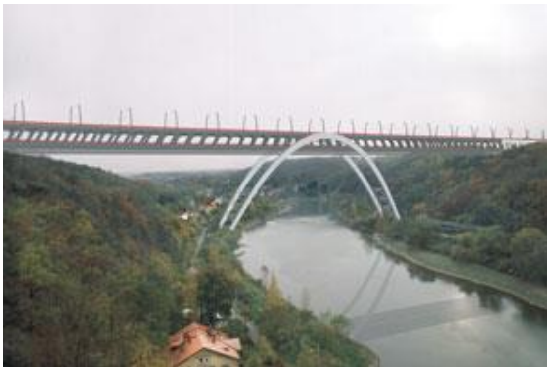
Obr. 13 Veirendeelův nosník – studie ČVUT
