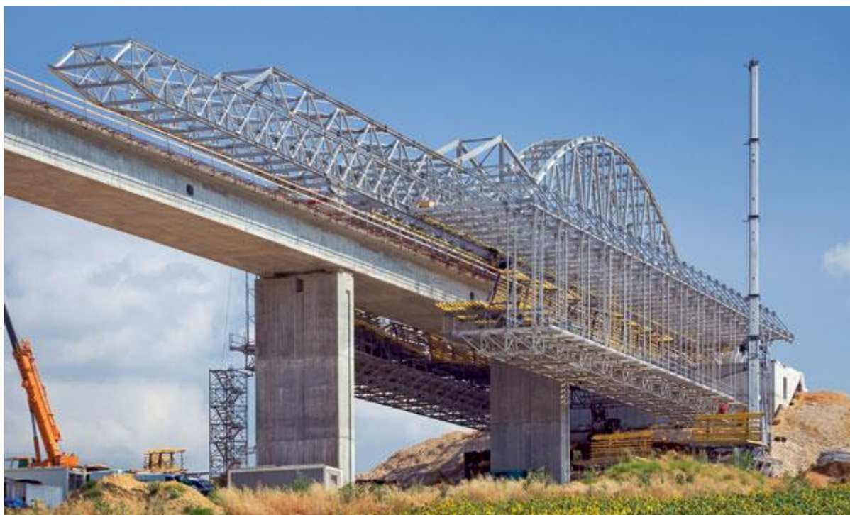
Obr.21 Ukázka výsuvné skruže
