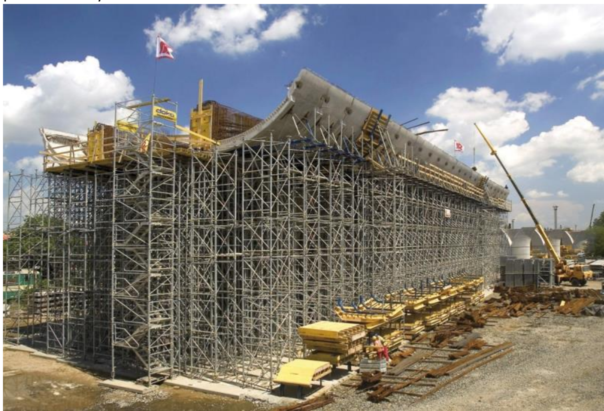
Obr. 18 Ukázka pevné skruže
