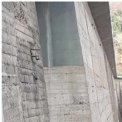
Obr. 7 - Zachycení smaltovaného štítku a odrazného minihranolu na bloku 30
