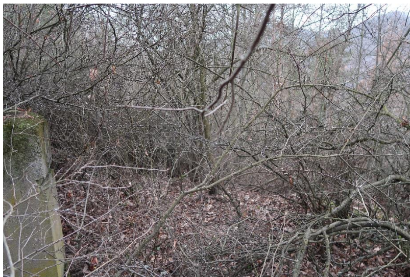
Obr. 19 - Ukázka stavu okolí a pohled směrem k hrázi z pilíře P2
