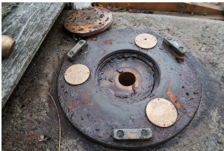
Obr. 13 - Znárodnění hlavy pilíře P5 s vyraženým důlkem
