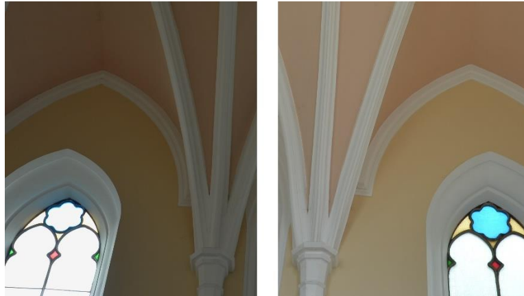
Obr. 24 Vlevo zastíněná stěna, vpravo osvětlená stěna
