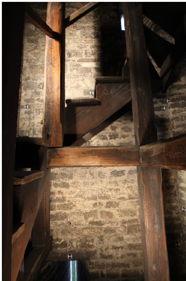
Obrázek 16: Ukázka stísněného prostoru věže
