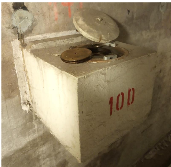
Obr. 7 Pozorovaný pilíř číslo 100 uvnitř 4. revizní chodby
