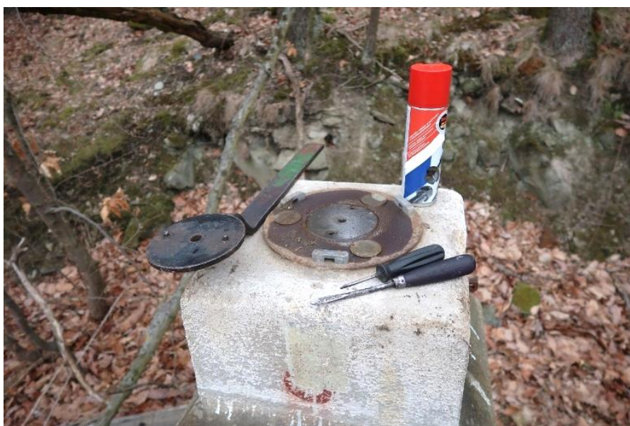
Obr. 8 Zkušební povolování krycí destičky na pilíři 8
