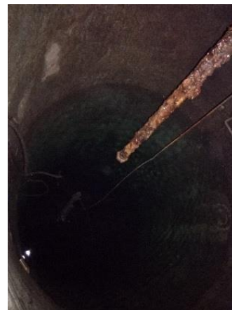
Obr. 32 – Studna pod č. p. 135
