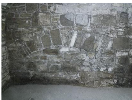
Obr. 38 – Klenba nad schodištěm do 2. patra
