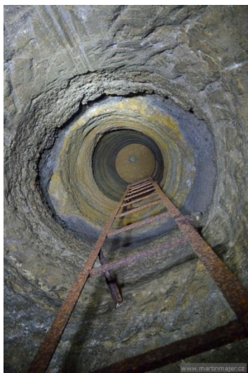
Obr. 11 – Vstupní šachta (M. Majer 2019)
