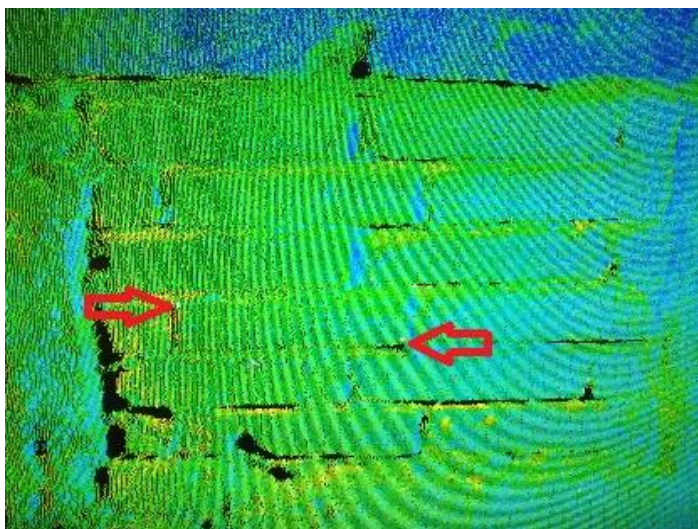
Obr. 61 – Příklad výběru podrobných bodů v mračnu bodů – levý horní roh a pravý dolní roh cihly
