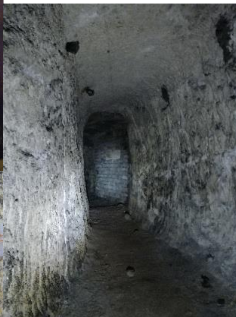
Obr. 29 – Chodba mezi č. p. 86 a č. p. 87
