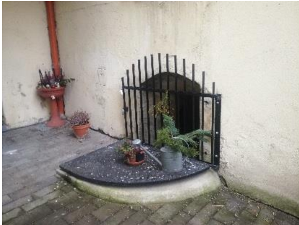
Obr. 16 – Vstup ze dvora u č. p. 86
