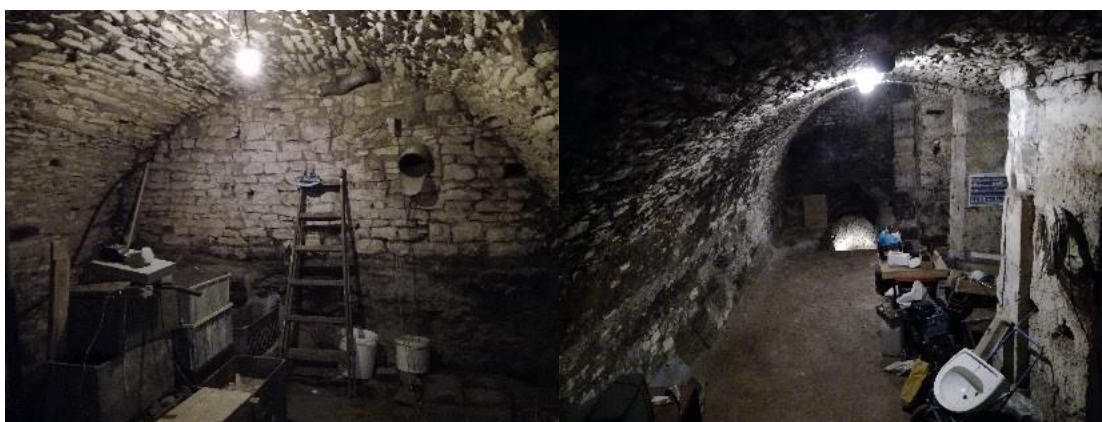
Obr. 21 a 22 – Místnosti v 1. patře pod č. p. 8 a č. p. 9
