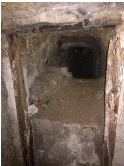
Obr. 26 – Chodba mezi č. p. 1 a č. p. 86
