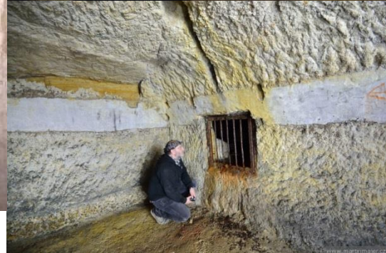
Obr. 27 – Propojení mezi č. p. 8 a č. p. 9
