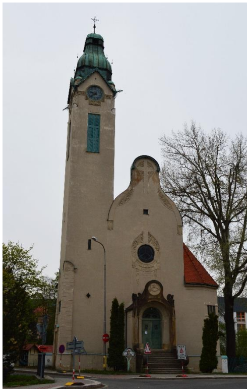
Obr. 7 Kostel Povýšení svatého Kříže (autor BP)
