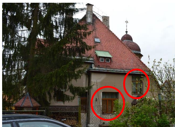
Obr. 43 Secesní stavba zezadu - výměna oken – jiné členění a barva (autor BP)
