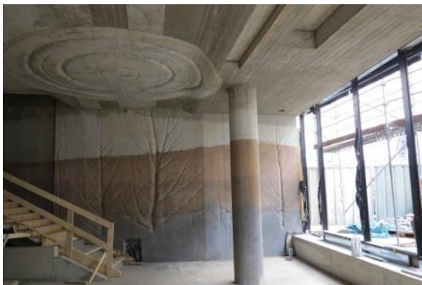
Obr. 39 Ukázka barevného betonu – Palác Národní, Praha (zdroj [41])
