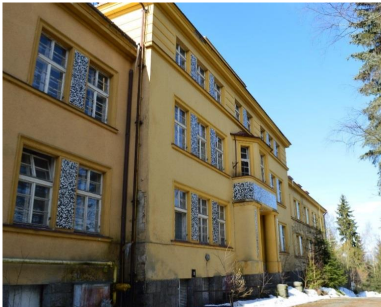
Obr. 20 Bývalá porodnice (autor BP)
