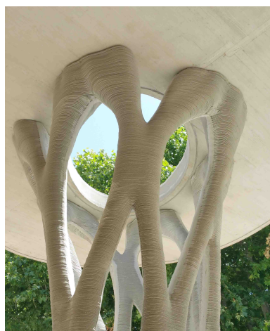
(a) Sloupový prvek vytvořený pomocí tisknutého bednění [23]
