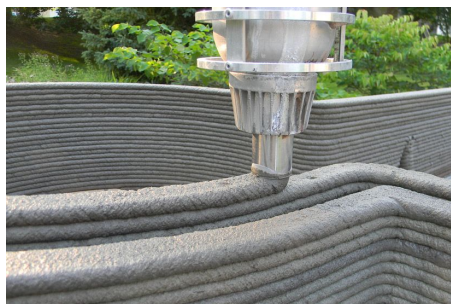
(a) Stěnový prvek vytvořený pomocí vytlačování cementového kompozitu [4]
