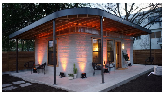
(b) Jednopatrový dům vytisknutý metodou vytlačování cementového kompozitu [5]
