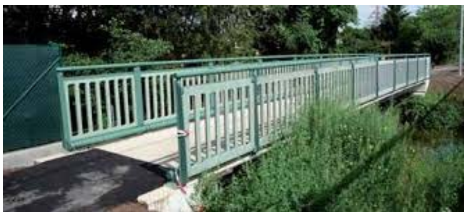
Obr. 10: Pohled na dokončenou lávku u obce Čeperka, která je provedena z UHPC třídy C110/130 XC4 XF3 – převzato z [36]
