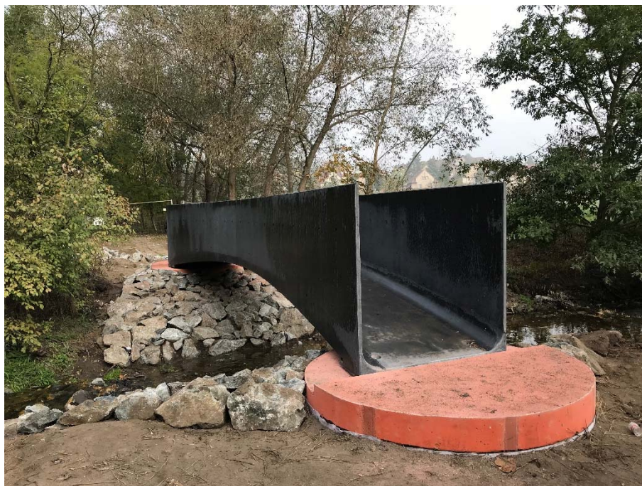
Obr. 15: Pohled na finální dvojitě zakřivenou lávku z UHPC na rozpětí 10 m instalovanou v obci Vrapice – fotografie z archivu Kloknerova ústavu
