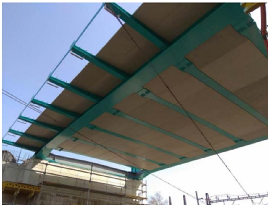
Obr. 11: Pohled na spodní líc silničního mostu SO 202 přes železniční trať č. 270 v Přerově – převzato z [31]
