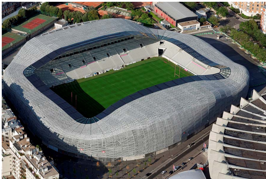
Obr. 25: Pohled na stadion Jean Bouin v Paříži s fasádními panely z UHPC – převzato z [55]
