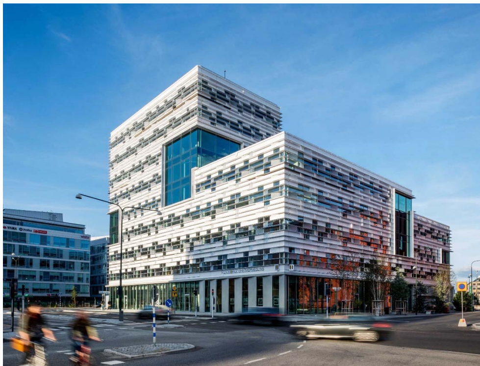
Obr. 24: Pohled na dokončenou administrativní budovu v Kontor v Malmö s fasádními panely z bílého UHPC – převzato z [53]
