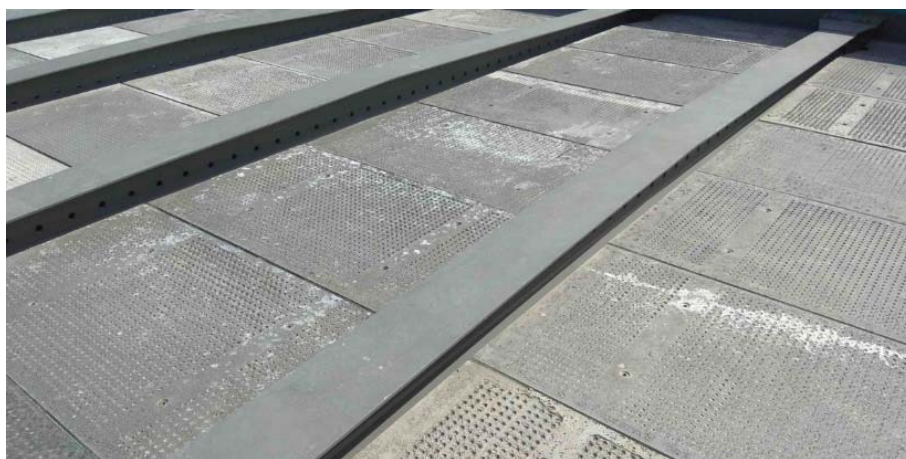
Obr. 12: Pohled na horní líc desek ztraceného bednění použitých při rekonstrukci mostů přes železniční trať v Přerově – převzato z [37]
