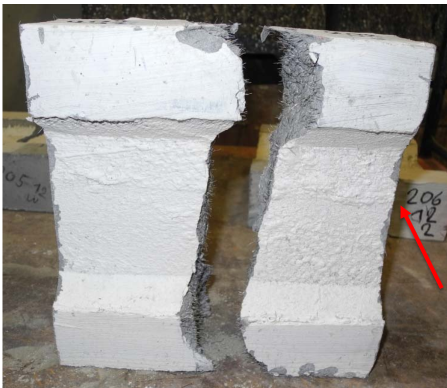
Obr. 76: Výřez nosníku R1 v místě makrotrhliny; šipkou označena řezná plocha, na které byla stanovena distribuce drátků
