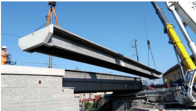
Obr. 16: Instalace předem přepravené lávky v Táboře s rozponem 27 m a příčným průřezem dvojitého T – převzato z [42]
