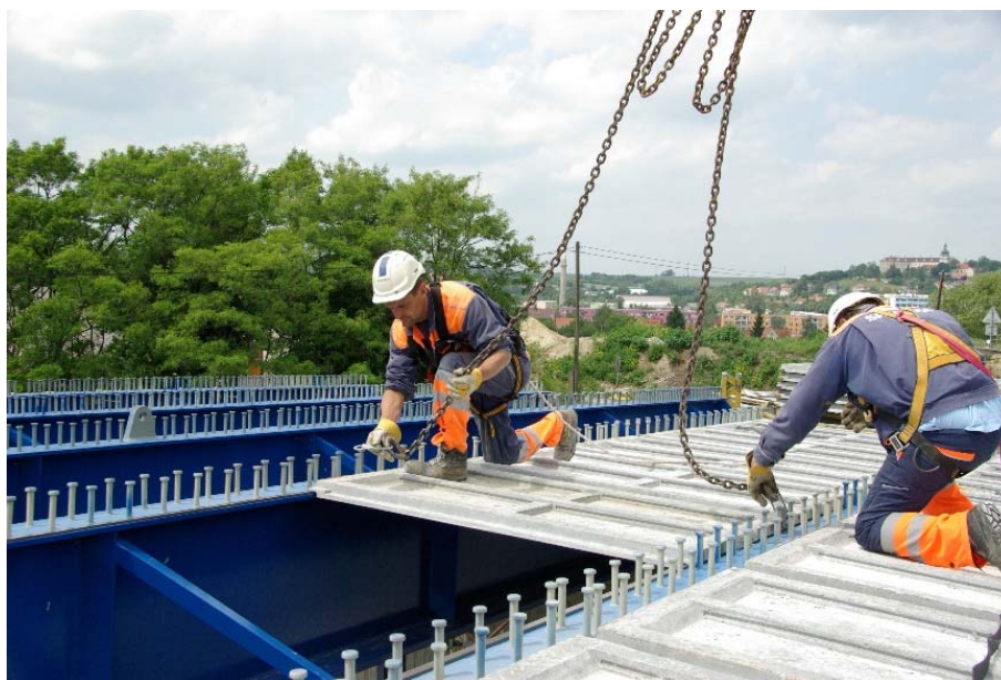
Obr. 6: Montáž desek ztraceného bednění z UHPC na mostu ev. č. 272-008 u Benátek nad Jizerou – převzato z [34]
