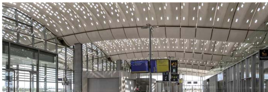
Obr. 26: Pohled do odbavovací haly vlakového nádraží v Montpellier zastřešenou panely z DUCTAL® [54]
