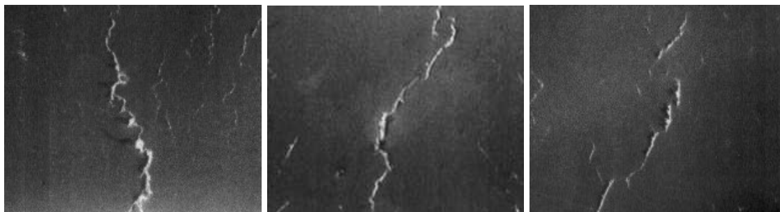
Obr. 113 Pohled na část čelní hrany betonové desky D1 s mikrotrhlinami, šířka trhlin dosahuje 10 až 20 \mu\text{m} (0,01 až 0,02 mm), délka asi 2 až 3 mm
