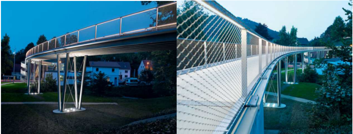
Obr. 35 Pohled na realizovaný most pro pěší v Albstadt-Lautlingen [2]
