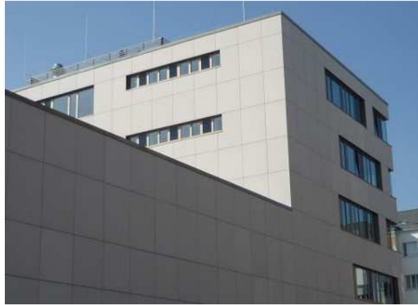
Obr. 46 Fasádní panely z TRC betonShell®BIG s rozměry až 2400 x 1200 mm, TU Dresden [64]
