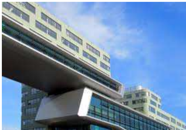
Obr. 45 Fasádní panely z TRC betonShell®BIG s rozměry až 2400 x 1200 mm, ROC Leiden Community College [64]
