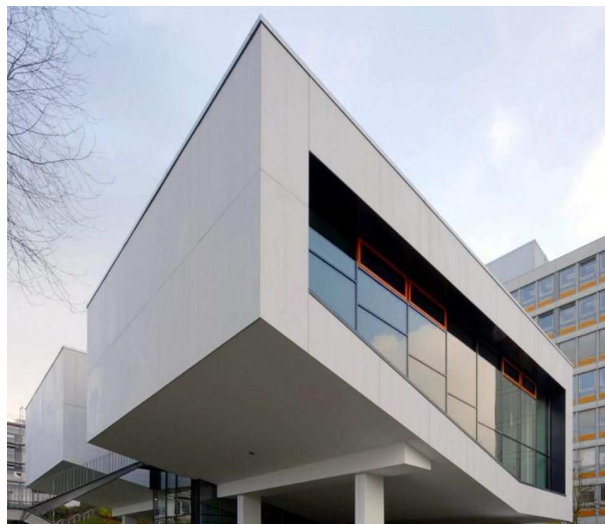
Obr. 47 Fasádní panely z TRC betonShell®XXL s rozměry až 6000 x 3000 mm, RWTH Aachen [64]
