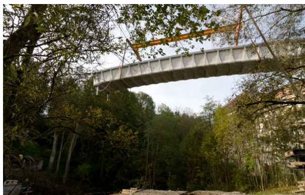
Obr. 40 Pohled na probíhající montáž lávky
