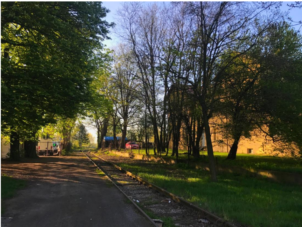
Vlečková kolej č. C2 před zadní stranou výpravní budovy [21.4.2018]
