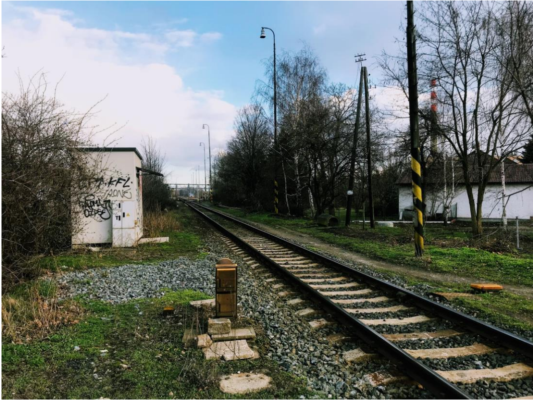
Měšické záhlaví, seřadovací návěstidlo Se7 [19.3.2019]
