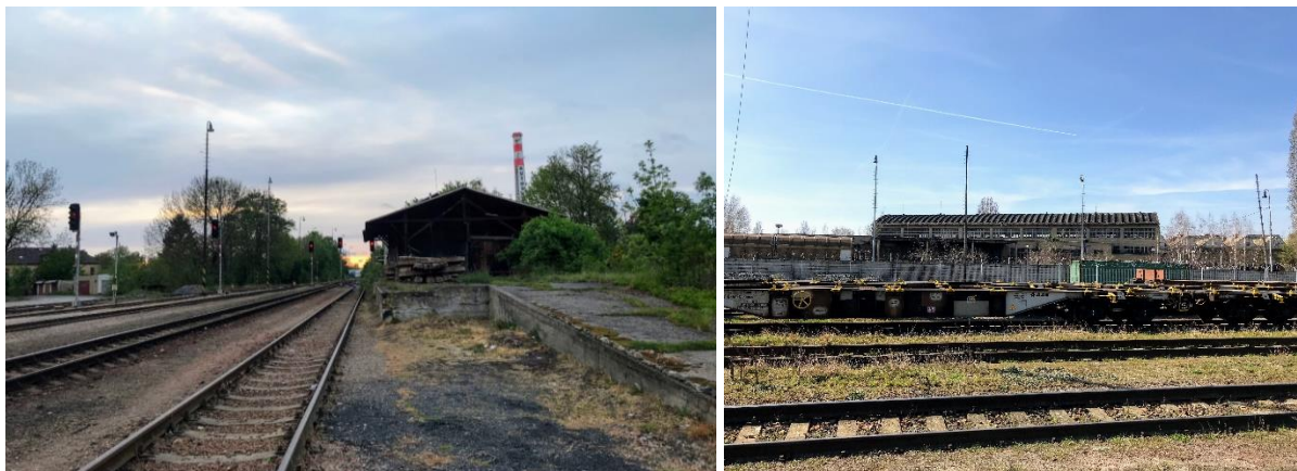
Obr. 20: Pohled na boční rampu se skladem a na odstavené plošinové vozy
