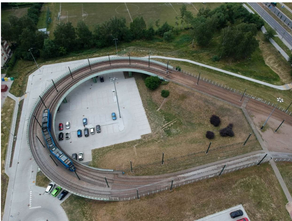
Obr. 23. Pętla tramwajowa Kurdwanów; ukázka tramvajové smýčky na mostě. Pod ní bylo zbudováno parkoviště P+R i s odstavem pro cyklisty a místy pro nabíjení elektromobilů. Autor: [55]
