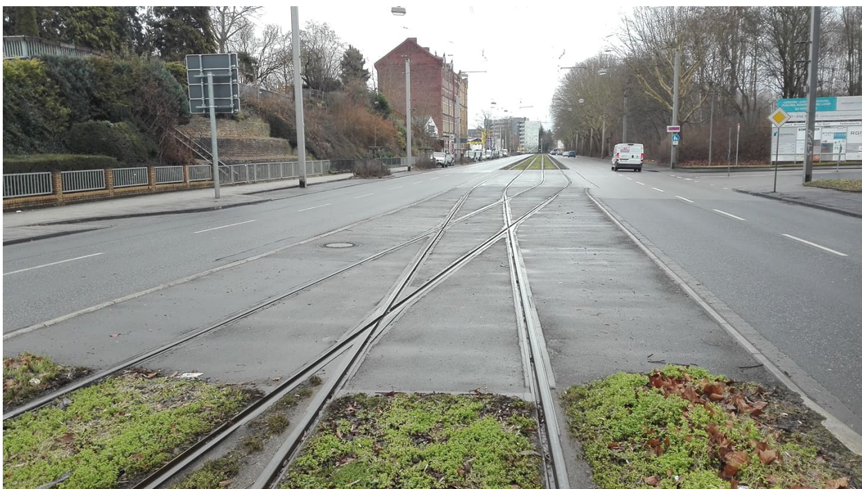
Obr. 22. kolejová křižovatka před terminálem VHD Hollandische Straße v Kasselu. Autor: Stanislav Metelka
