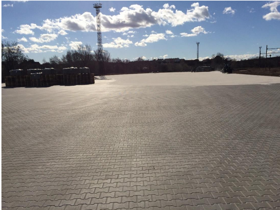
Obrázek č. 15: Výstavba nové skladovací plochy; zdroj: [autor]
