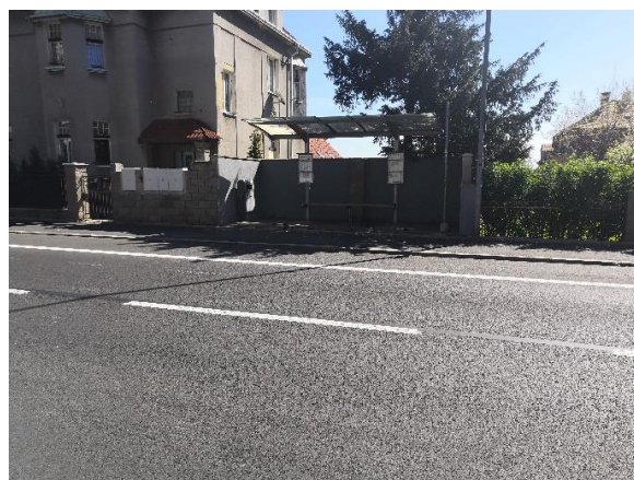
Obrázek 15 - Absence prvků pro OOSPO a nedostatečná výška nástupní hrany v ulici Tyršova (zdroj: Tereza Dalecká)
