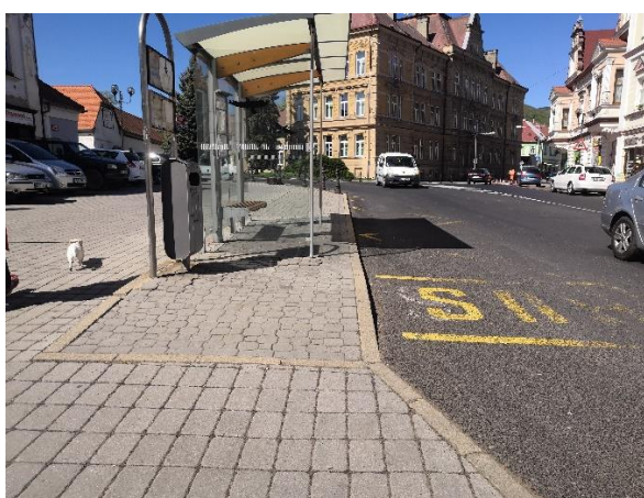
Obrázek 16 – Absence prvků pro OOSPO a SDZ, nedostatečná výška nástupní hrany a šířka zastávky v ulici Náměstí Klášterní (zdroj: Tereza Dalecká)
