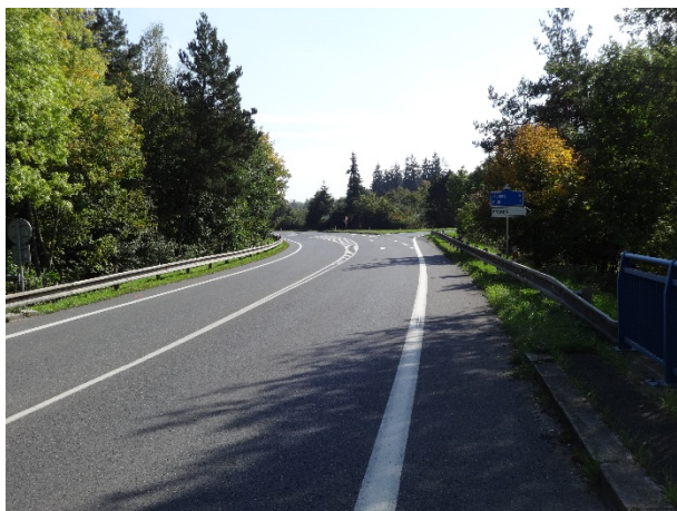
Obrázek 2 – Pohled na sledovanou lokalitu ze severního ramene křižovatky (silnice I/66).
