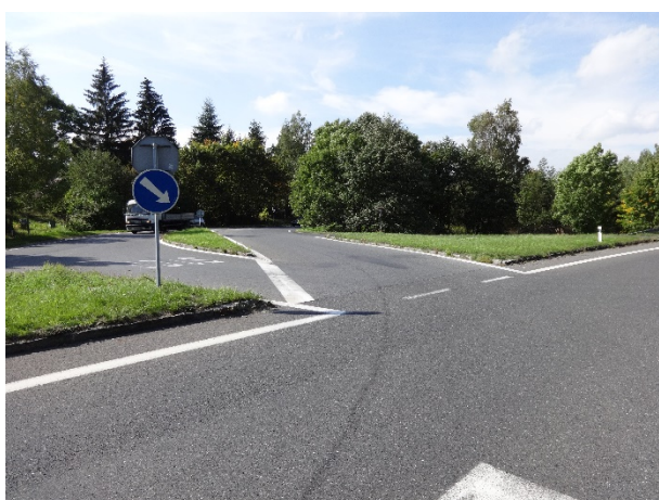
Obrázek 6 – Pohled na nevhodný tvar středního dělicího ostrůvku v místě západního ramene křižovatky (silnice III/1912).
