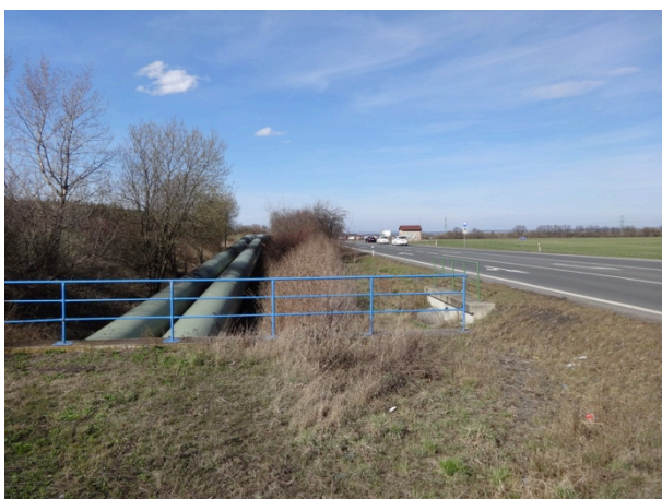
Obrázek 6 – Ukázka teplovodu nacházejícího se podél severního ramene křižovatky.
