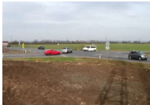
Obrázek 17 – Ukázka rizikového připojení na hlavní komunikaci, v jehož důsledku došlo k ohrožení vozidel jedoucích po vedlejší komunikaci.
