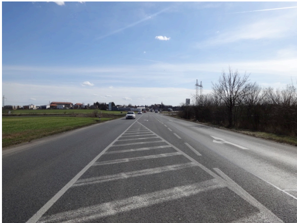
Obrázek 2 – Pohled na sledovanou lokalitu ze severního ramene křižovatky (silnice I/9).
