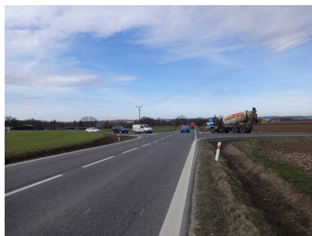
Obrázek 3 – Pohled na sledovanou lokalitu z východního ramene křižovatky (silnice I/2).
