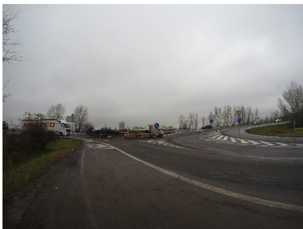
Obrázek 15 – Pohled na nově postavenou okružní křižovatku z východního ramene křižovatky (silnice III/24637).
