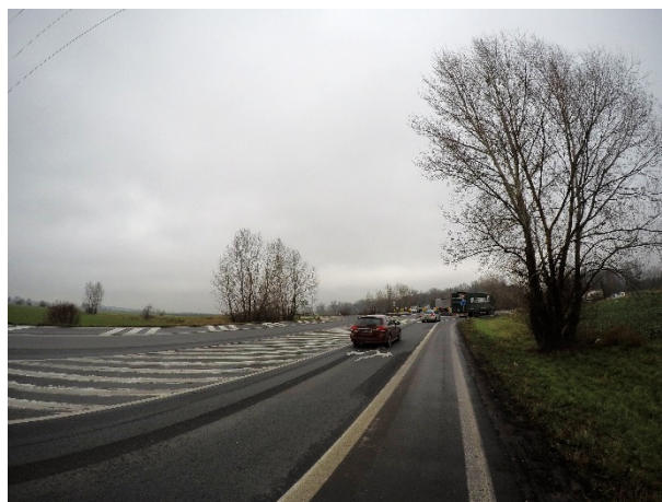
Obrázek 16 – Pohled na nově postavenou okružní křižovatku z jižního ramene křižovatky (silnice I/16).
