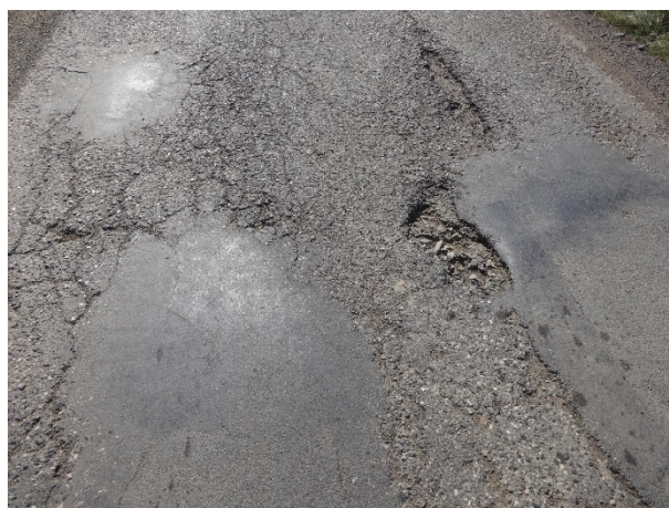
Obrázek 7 – Bližší pohled na neadekvátní technický stav vozovky v místě severního ramene křižovatky (vedlejší účelová komunikace).
