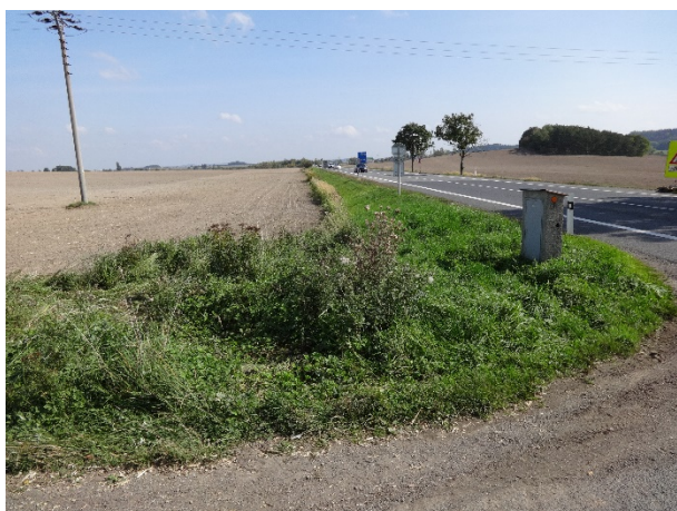
Obrázek 6 – Bližší pohled na bezpečnostní deficit (betonový sloupek) nacházející se v místě mezi severním a východním ramenem křižovatky.
