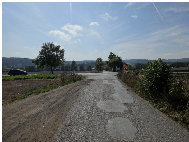
Obrázek 2 – Pohled na sledovanou křižovatku ze severního ramene křižovatky (vedlejší účelová komunikace).
