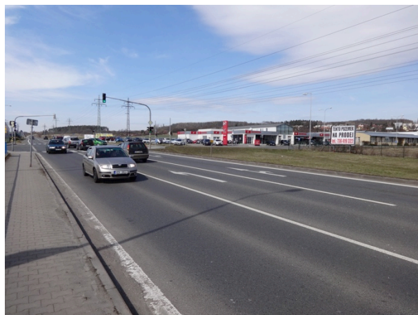
Obrázek 3 – Pohled na sledovanou lokalitu z východního ramene křižovatky (silnice I/38).
