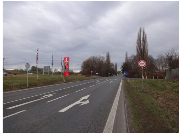
Obrázek 3 – Pohled na sledovanou lokalitu z východního ramene křižovatky A (silnice I/12).
