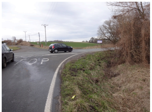
Obrázek 7 – Ukázka vzrostlé zeleně omezující rozhledové poměry v místě mezi severním a západním ramenem křižovatky A.
