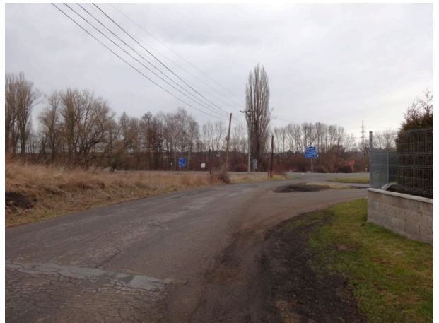
Obrázek 5 – Pohled na sledovanou lokalitu z jižního ramene křižovatky A (silnice III/113 3).
