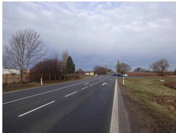
Obrázek 9 – Pohled na sledovanou lokalitu z východního ramene křižovatky B (silnice I/12).
