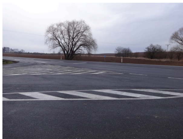
Obrázek 13 – Názorná ukázka rizikové polohy vzrostlého stromu nacházejícího se mezi severozápadním a západním ramenem křižovatky B.
