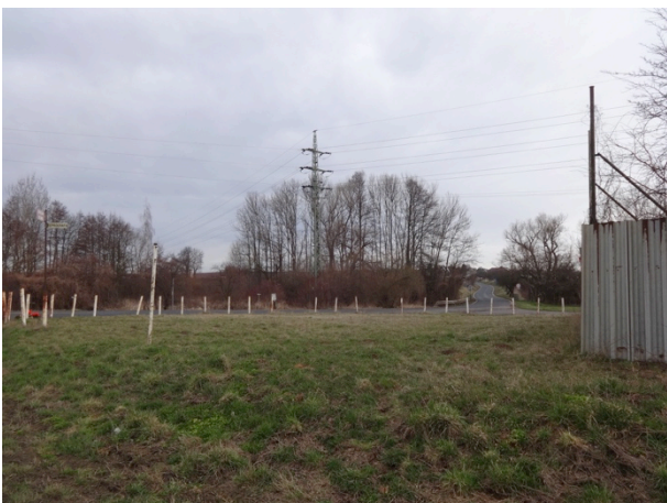
Obrázek 6 – Bližší pohled na bezpečnostní deficit (tuhá ocel. konstrukce) nacházející se mezi severním a východním ramenem křižovatky A.
