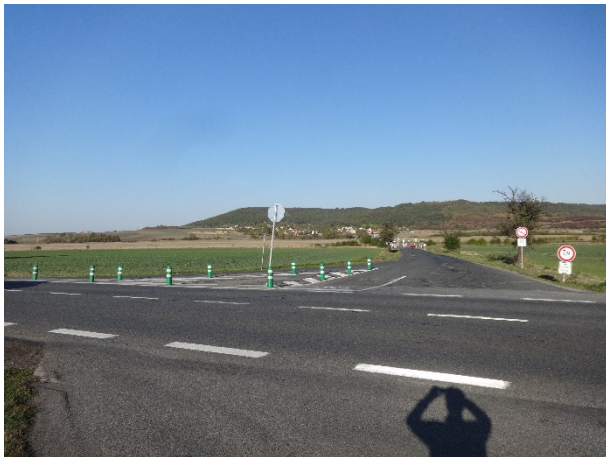
Obrázek 4 – Pohled na sledovanou lokalitu, východní rameno křižovatky (silnice III/010 13).
