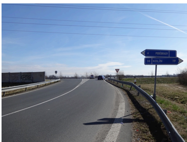
Obrázek 4 – Pohled na sledovanou lokalitu ze západního ramene křižovatky (silnice II/503), v místě nakolmení vedlejší PK na hlavní.
