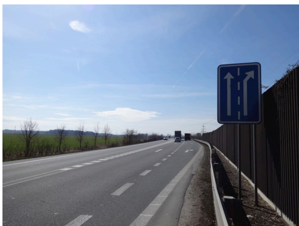
Obrázek 2 – Pohled na sledovanou lokalitu ze severního ramene křižovatky (silnice I/38).
