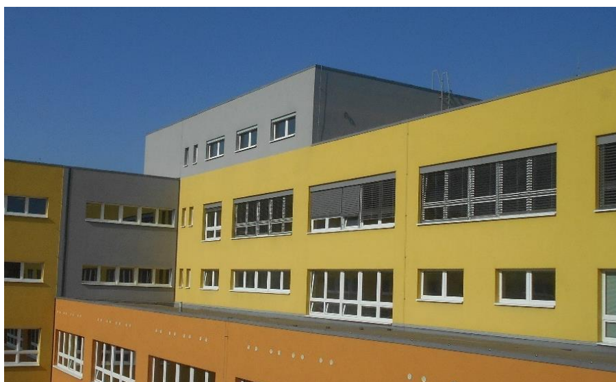
Obrázek 17 Pohled na PC učebnu v nejvyšším patře pořízen na místě
