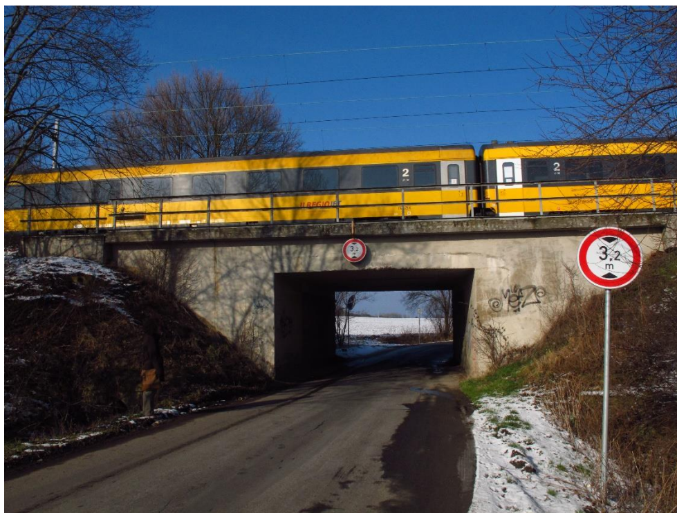
Obrázek 50. Omezení výšky projíždějících vozidel na silničním podjezdu pod železniční tratí č. 010
