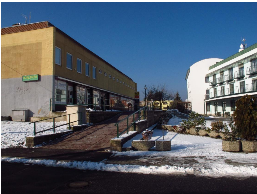
Obrázek 5. Budova pošty (vlevo) a Domov pro seniory na náměstí Svobody
