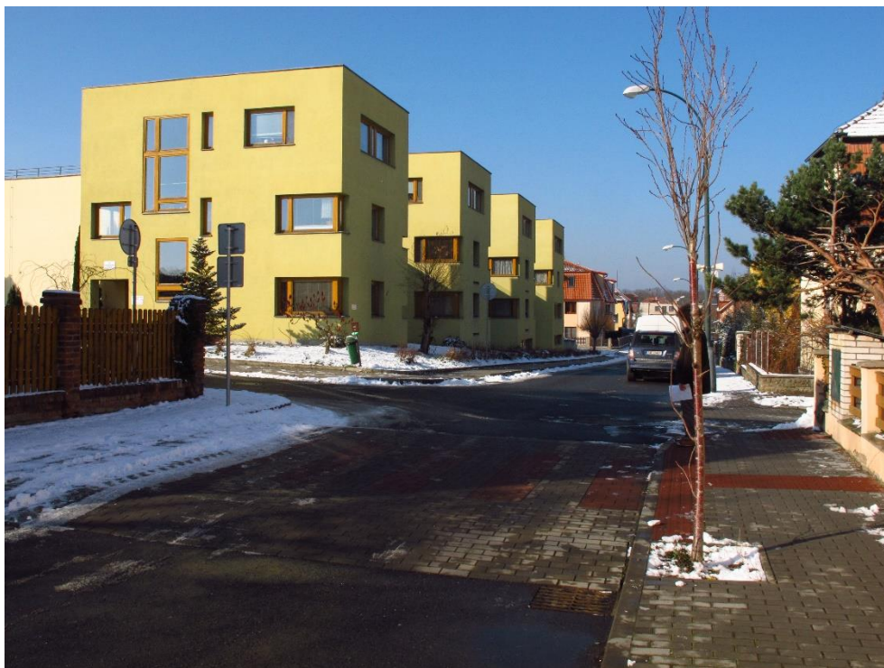
Obrázek 7. Zpomalovací práh s přechodem pro chodce v ulici V. Novák
