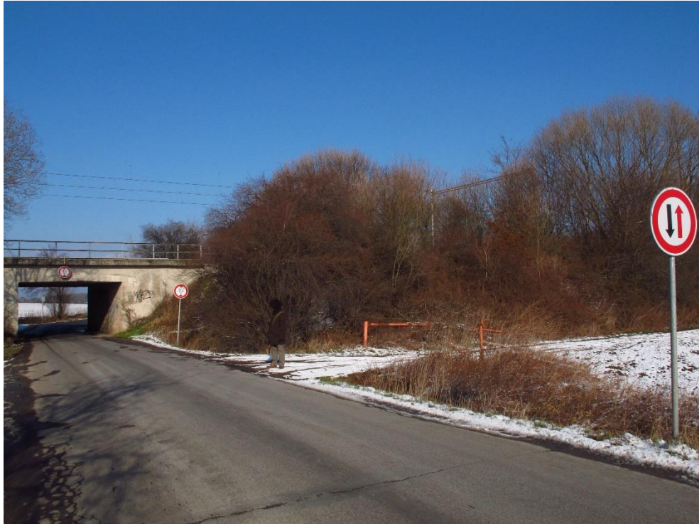
Obrázek 51. Silniční podjezd pod železniční tratí č. 010 se SDZ P 7 „Přednost protijedoucích vozidel“ a místo budoucího umístění křižovatky na S III/10163
