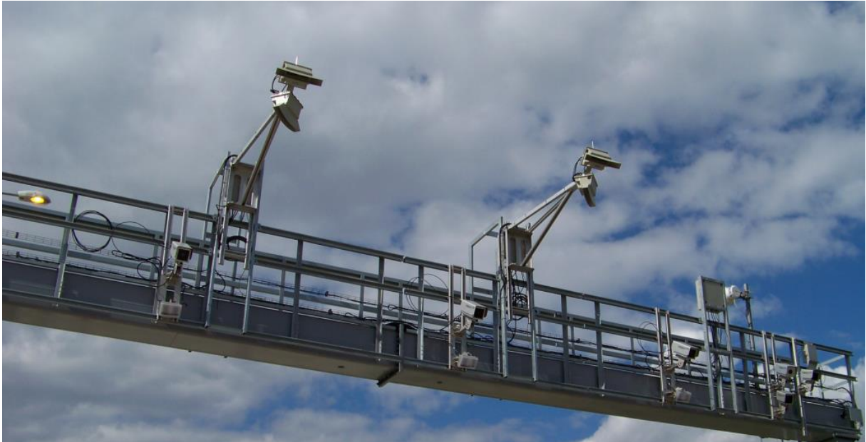
Obrázek 7 - Mýtná brána s enforcementem v ČR na bázi DSRC 5,8 od společnosti KAPSCH [16]
