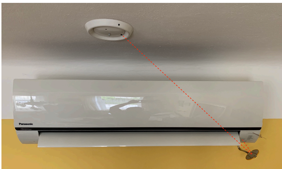
Obrázek C.2: Klimatizační jednotka „pokojík“ – V levé horní části (stará krabice od routeru) je umístěna jednotka s IR ovládním. Aby se signál dostal od vysílače k přijímači muselo být použito zrcátko. Červenou přerušovanou čarou je naznačen směr IR vysílání.
