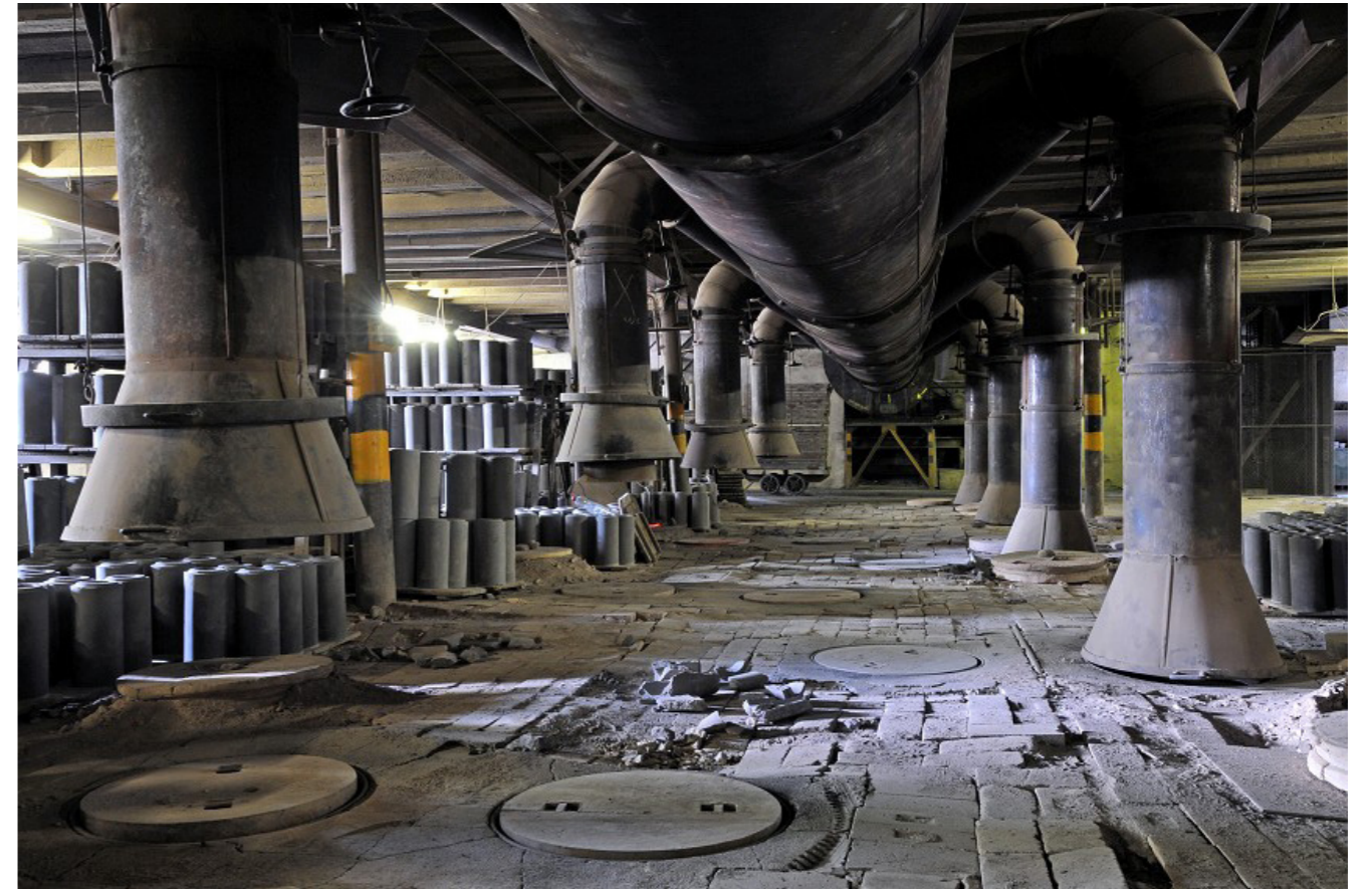
Původní vzduchotechnika
