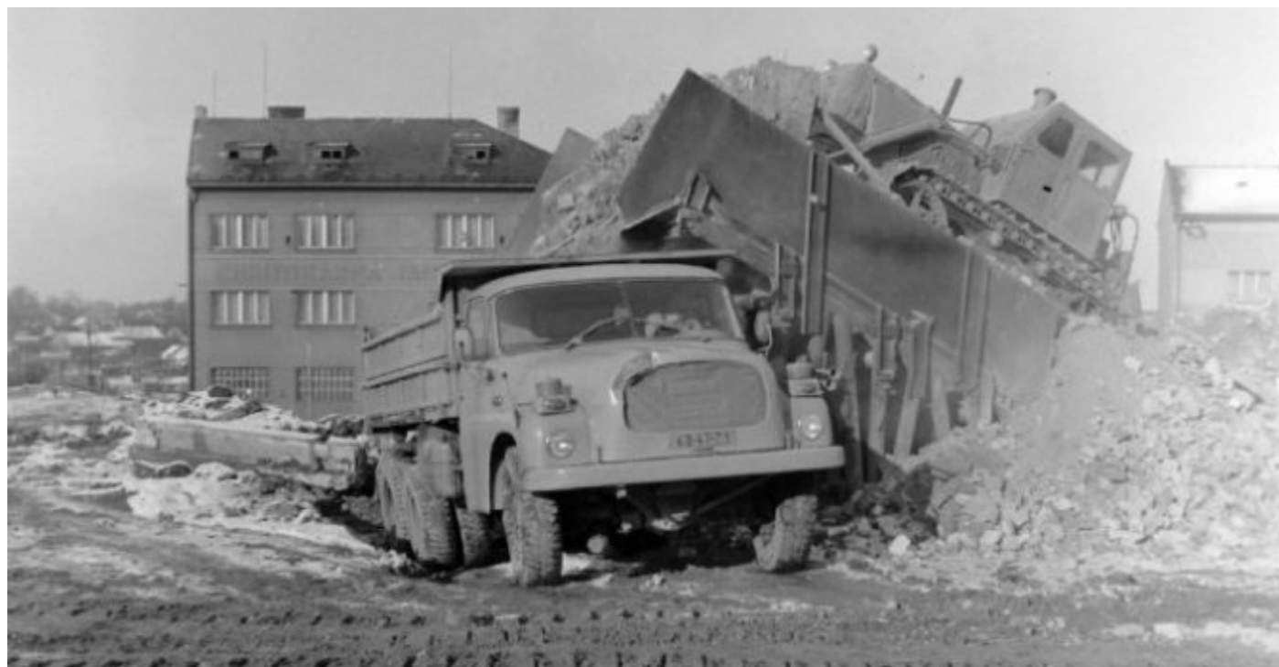
Nakládací rampy pro buldozéry při bourání Nového Kladna (foto F. Pošta, archiv T. Roučka)
