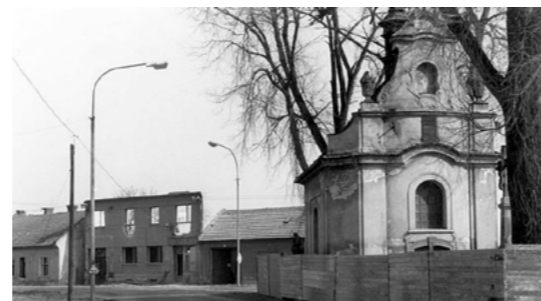
012 Demolice dolního Povlu v okolí kaple v roce 1987
