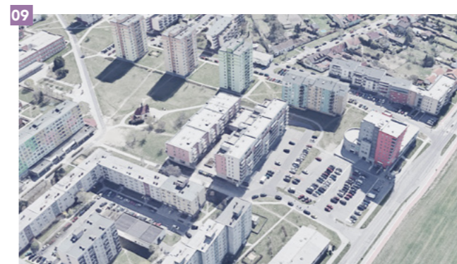
010 bývalé centrum obce Povel a subcentrum lokality
