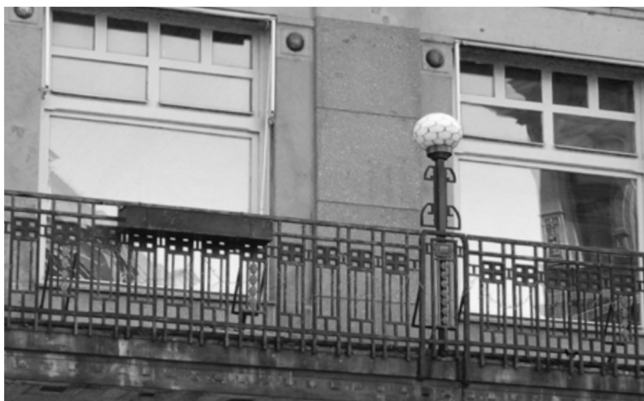
← zábradlí na balkoně Hotelu Praha ↓ most přes řeku Nisu
