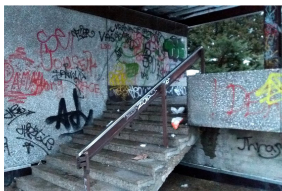
obr. 18: terasa budovy bazénu
