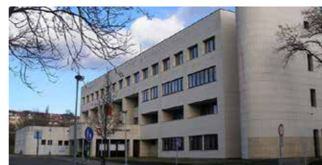
7. hlavní budova úřadu MČ Praha 8 tzv. Bílý dům, postaven na konci 80. let, jeho budoucnost je po plánovaném přesunutí úřadu nejistá
