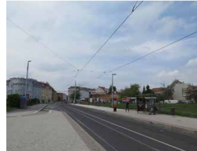
1. fotografie současného stavu pohled nahoru ulicí Zenklovou, tramvajová zastávka
