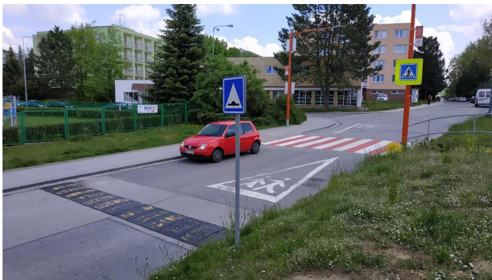
Obrázek 17: Vizuálně a příčným prahem zvýrazněný přechod pro chodce před základní školou
