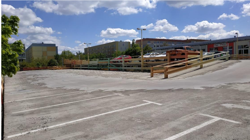
Obrázek 51: Parkovací dům s o půl patra posunutým parkingem a polorampami ve Zwickau, Německo
