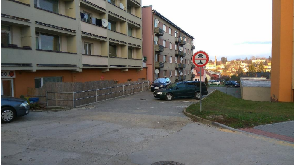
Obrázek 36: Parkovací místa vyznačená na ploše pro požární techniku
