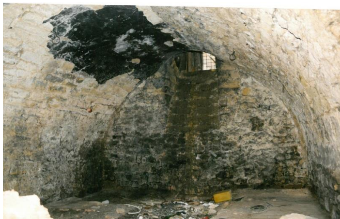
Dům čp. 17, zadní sklep, pohled k dvorní stěně.
