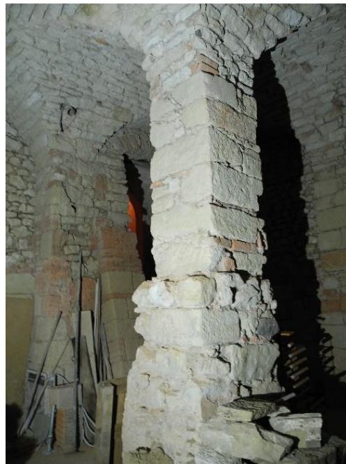
Dům čp. 86, přední sklep s pohledem na střední pilíř klenby. Sklep byl druhotně prohlouben.
