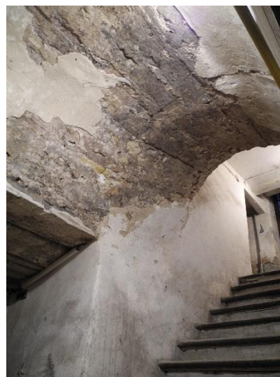
Dům čp. 27, schodiště ke sklepům. Vlevo částečně viditelné trámky překladu vstupu do zadního sklepa
