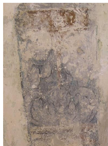
Dům čp. 88, detail malby na klenbě.
