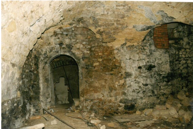
Dům čp. 17, přední sklep, vlevo vstup s portálem sesazeným z druhotně použitých ostění.
