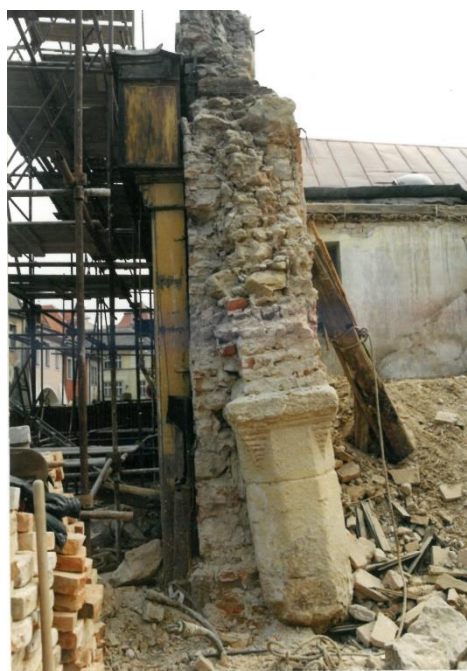
Pilíř gotického loubí odhalený při demolici domu čp. 100.
