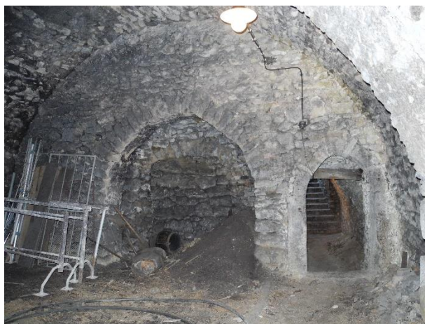
Přední sklep pod domem čp. 29 s pohledem k čelní stěně zadního sklepa. Výklenek uprostřed je pozůstatkem původního vstupu.
