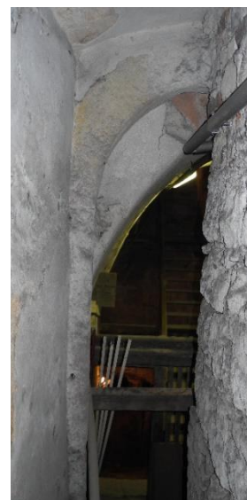
Pohled k portálu z bývalé vstupní šíje z podloubí
