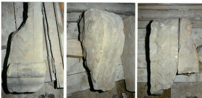
Mladá Boleslav, dům čp. 16, dokumentace architektonických článků druhotně zazděných v obvodových stěnách (výběr), E. Vyletová, 1997.
