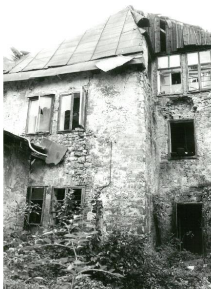
Dům čp. 12, pohled ze dvora, stav 1994.
