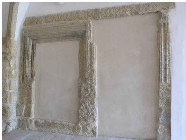
Portál ze síně do bočního klenutého prostor, pískovcový překlad je pozůstatkem profilované římsy, z níž se zachoval otisk.
