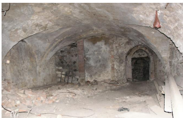
Dům čp. 25, zadní sklep (polozapuštěná komora), pohled ke vstupu.
