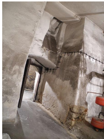
Dům čp. 27, přední sklep, pohled ke vstupu do sklepa pod bývalým podloubím.
