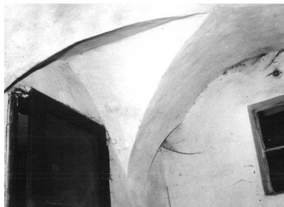
Dům čp. 12, detail klenby prostoru před vstupem do zadní komory v přízemí
