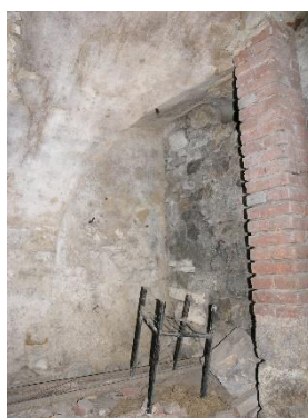
Detail výklenku v levém rohu přední stěny
