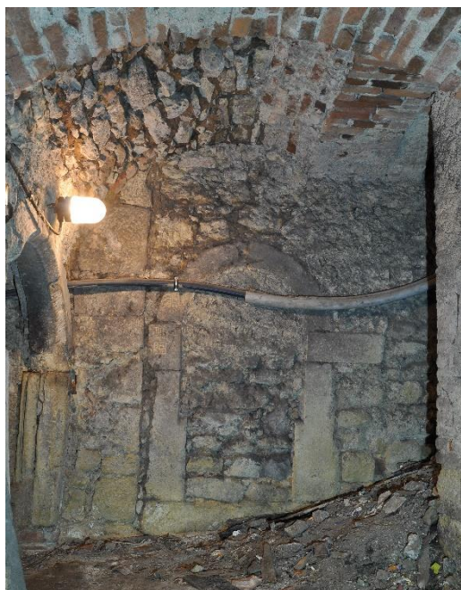
Portál v dělicí stěně mezi sklepy domů čp. 28 a 29
