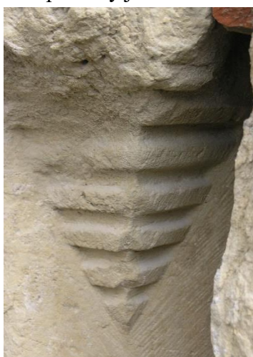
Dům čp. 86, zazděný pilíř podloubí v průběhu odstranění zazdívky, detail hlavice a patky.
