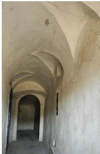
Dům čp. 94, průchod do dvora, pohled k druhotně osazenému portálu ze síně.
