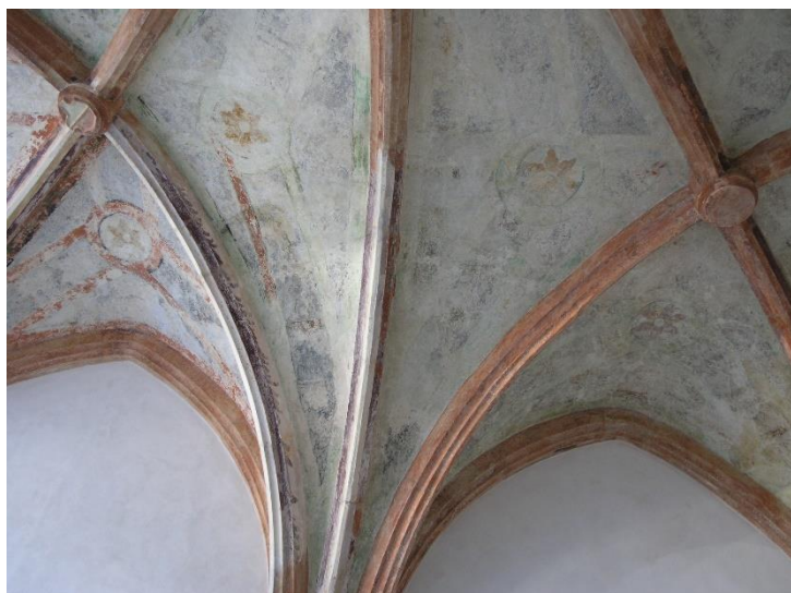
Dům čp. 88, pohled na klenbu s renesanční malbou.
