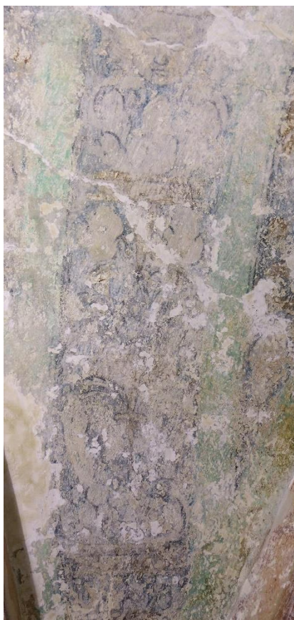
Dům čp. 88, detail malby na klenbě.
