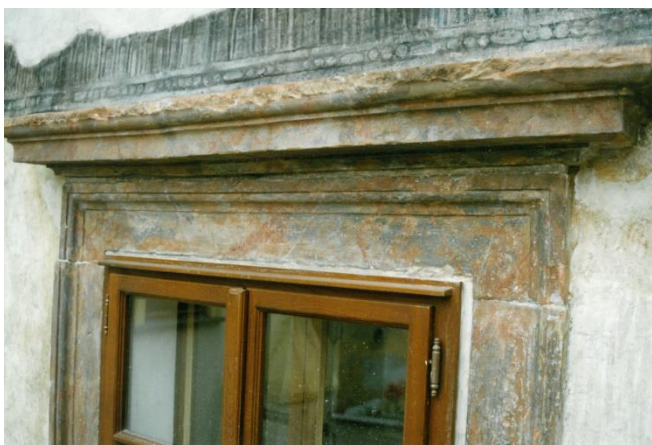
Dům čp. 16, průčelí dvorního křídla, detail ostění okna s fragmenty renesanční malby (D. Talavera, restaurátorská zpráva)
