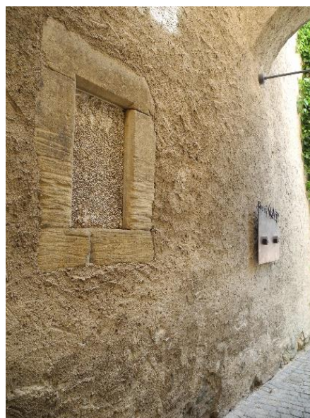
Dům čp. 104, stěna do bočního průchodu s pozdně gotickým ostěním okna.
