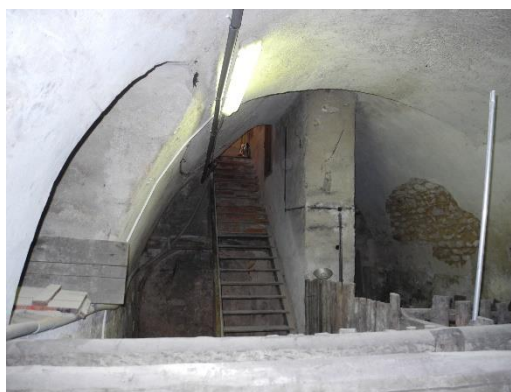
Dům čp. 19, přední sklep, pohled od čelní stěny k stávajícímu vstupu. Výklenek vlevo je pravděpodobně pozůstatkem propojení se sousedním objektem.
