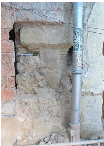
Dům čp. 86, zazděný pilíř podloubí v průběhu odstranění zazdívky, detail hlavice a patky.
