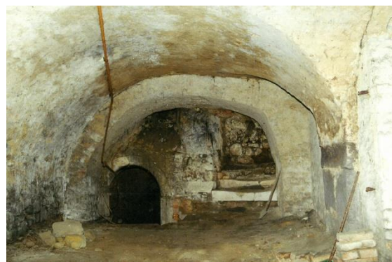
Dům čp. 12, přední sklep s pohledem k bývalé vstupní šíji z náměstí (vpravo), vlevo sestup do spodních sklepů tesaných ve skále
