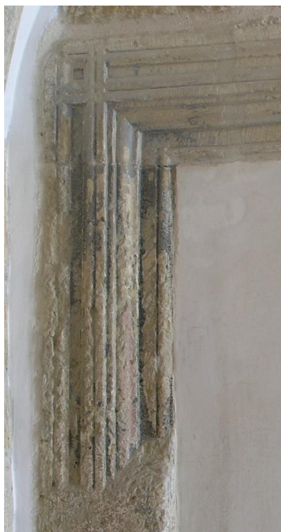
Dům čp. 88, detail ostění portálu v síni.
