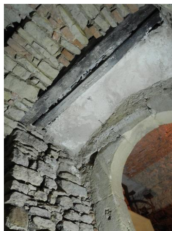
Dům čp. 86, portál do předního sklepa a detail záklenku špalety
