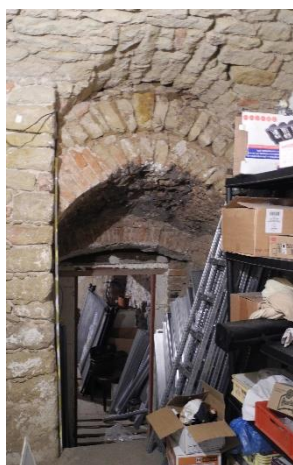
Dům čp. 86, vstup do sklepa pod komorou.
