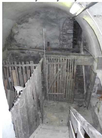
Dům čp. 19, přední sklep, pohled k čelní stěně s částečně zazděným otvorem bývalého vstupu na schodišťovou šíji z podloubí
