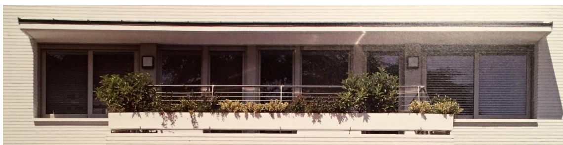
Obr. 95 Pásová okna a jižní stínění – příklad
