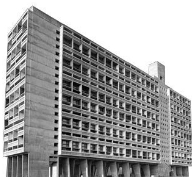
Obr. 9 Unité d'Habitation (1947–52) Le Corbusier – Marseille 31
