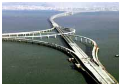
Most přes zátoku Jiaozhou, Čína
