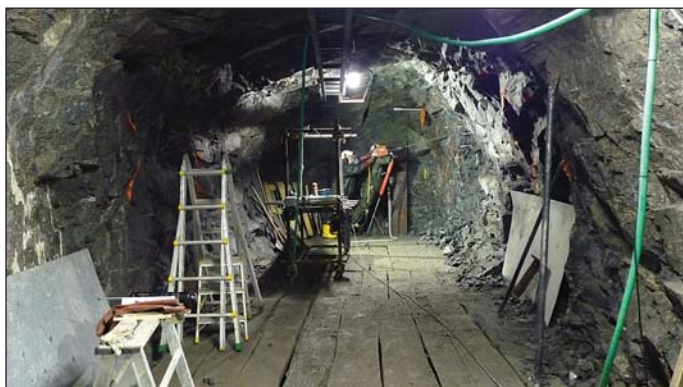
Obr. 2 Práce v rozrážce SP-59 Fig. 2 Work in gallery niche SP-59
