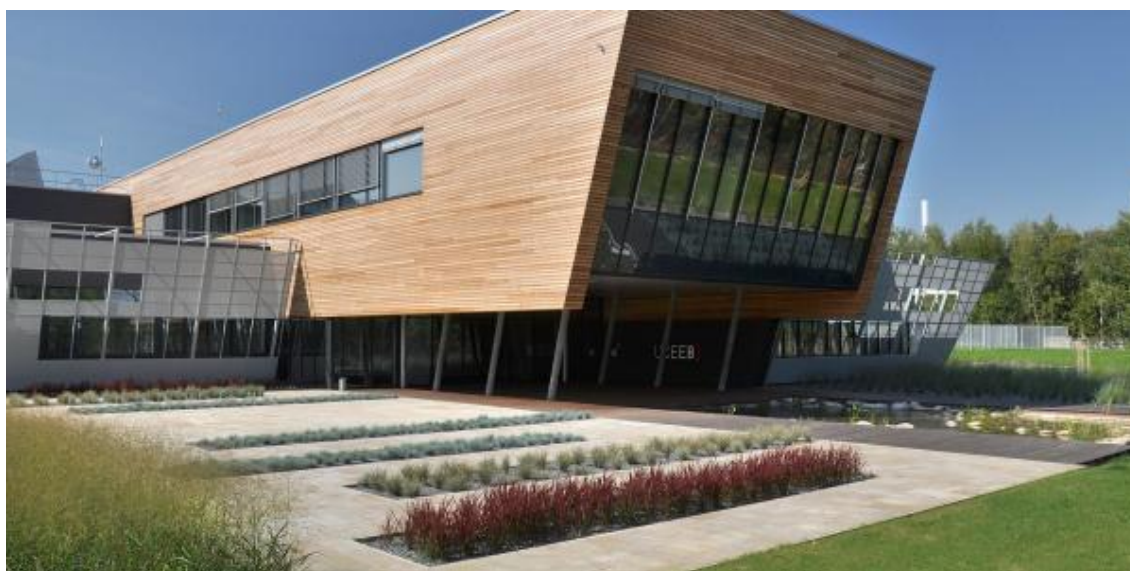
obr. 3: Dřevěný obklad na fasádě, budova UCEEB ČVUT v Praze © M. Žitníková
