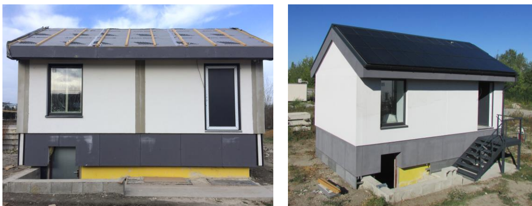
obr. 32: Konečné scelení fasády panelů
