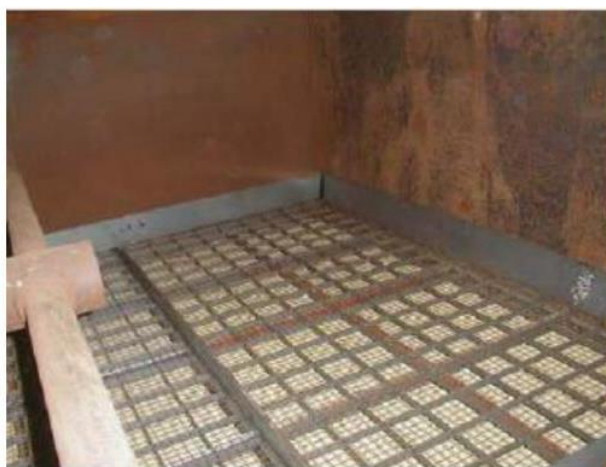
Obr. 22 - Katalyzátor s tvarovým průřezem honeycomb [2]
