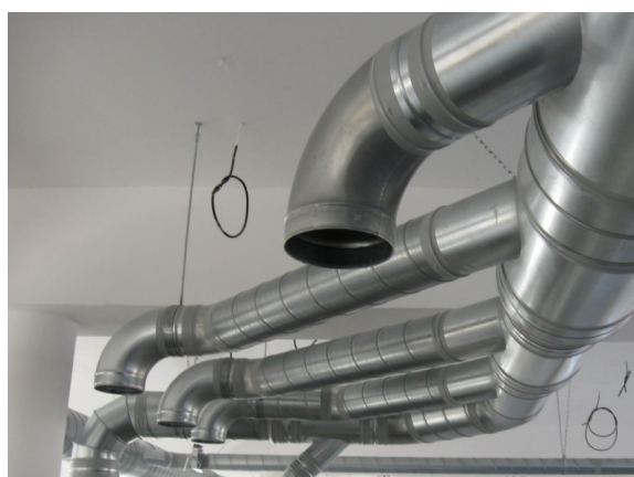
Obrázek 13 - Vzduchotechnické rozvody
