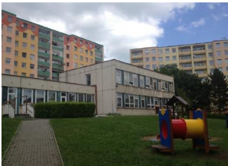
Obrázek 3 Foto objektu před rekonstrukcí (Energetický audit, 2013)
