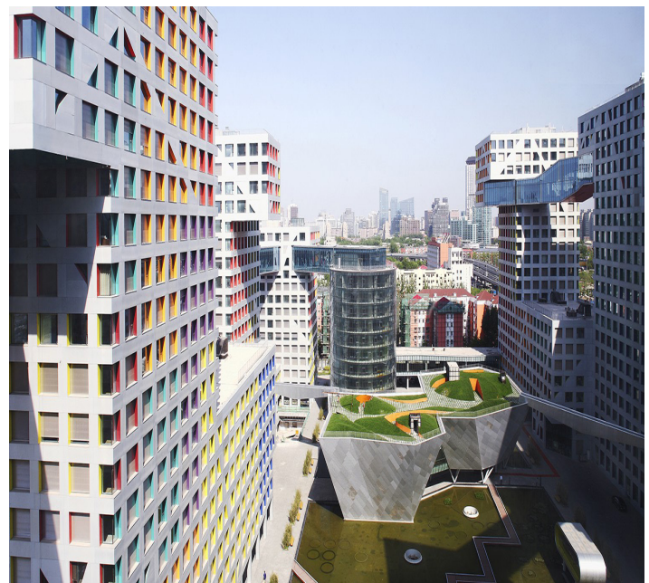
Obr. č. 8 Linked Hybrid / vnitroblok, pohled z okna
