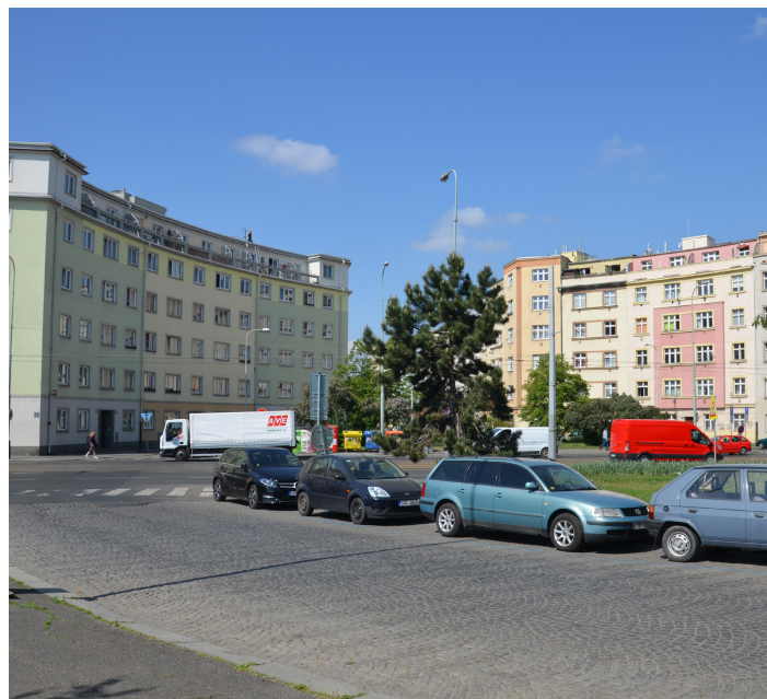
Obr. č. 24 pohled Basilejské nám., současný stav
