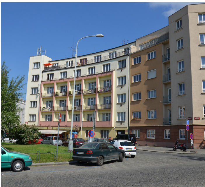
Obr. č. 25 pohled Basilejské nám., současný stav
