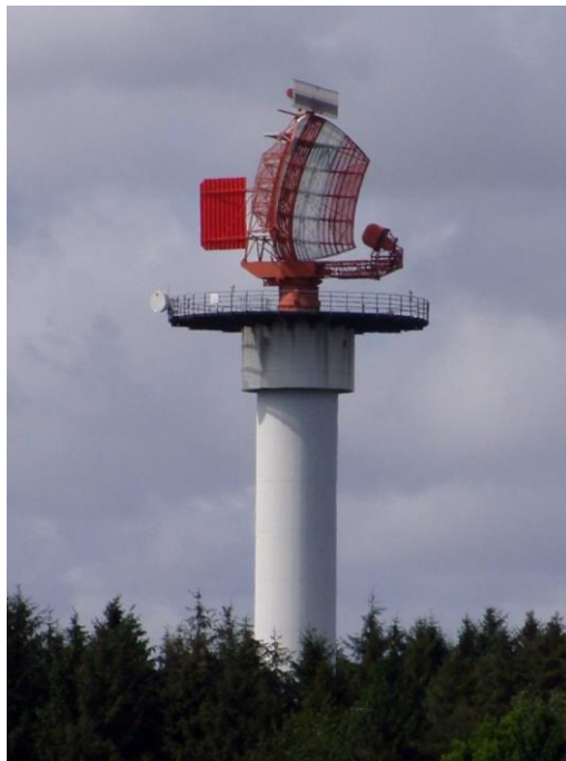
3.1.1-2 Traťový přehledový radiolokátor SRE-M na radiolokačním stanovišti Nordholz
