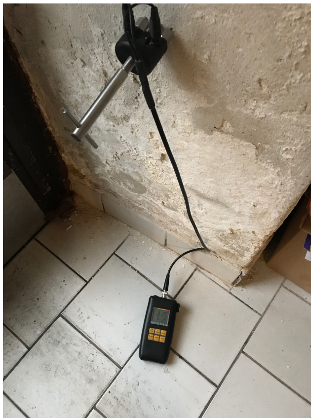
Obrázek 38: Měření ve spodní části obvodového zdiva z interiéru
