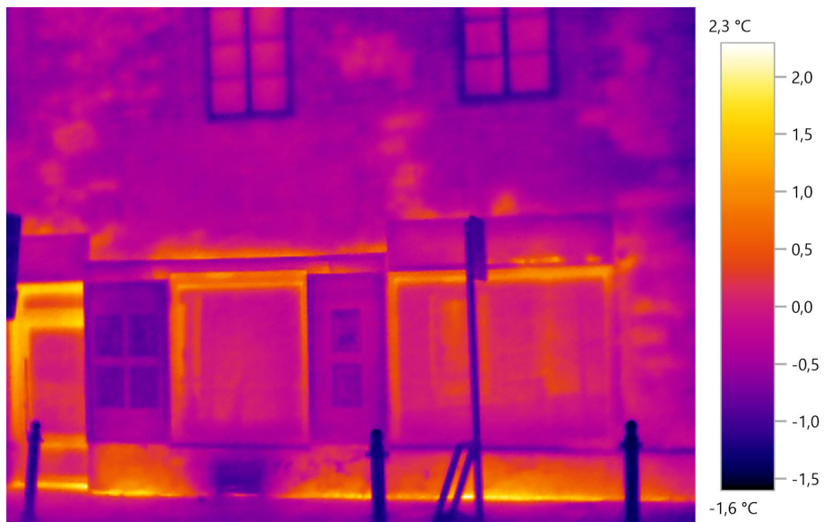
Obrázek 45: Termovizní snímek – pohled severní (vykreslení různých typů zdiva v horní části)
