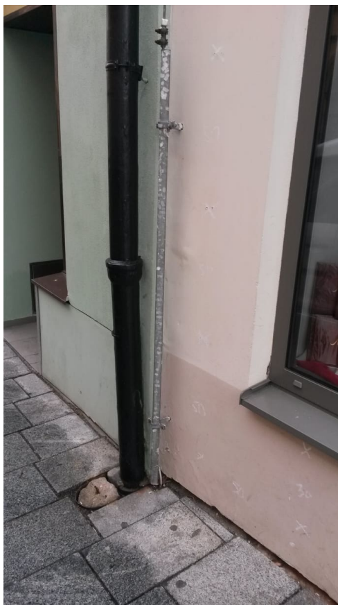
Obrázek 31: Svod na severní fasádě – bez poruch
