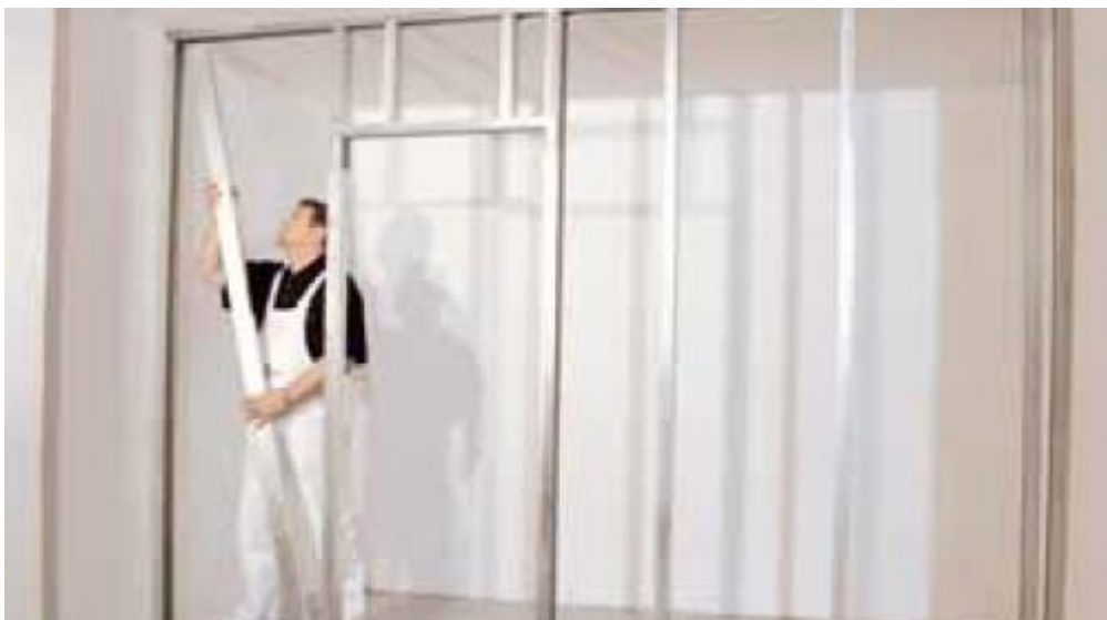
Obr. 14: Montáž nosné kce příčky – svislé profily R-CW [7]
