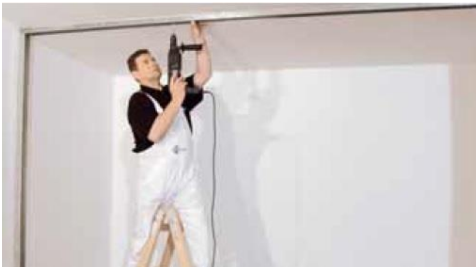
Obr. 13: Montáž nosné kce příčky – obvodové profily R-UW [7]
