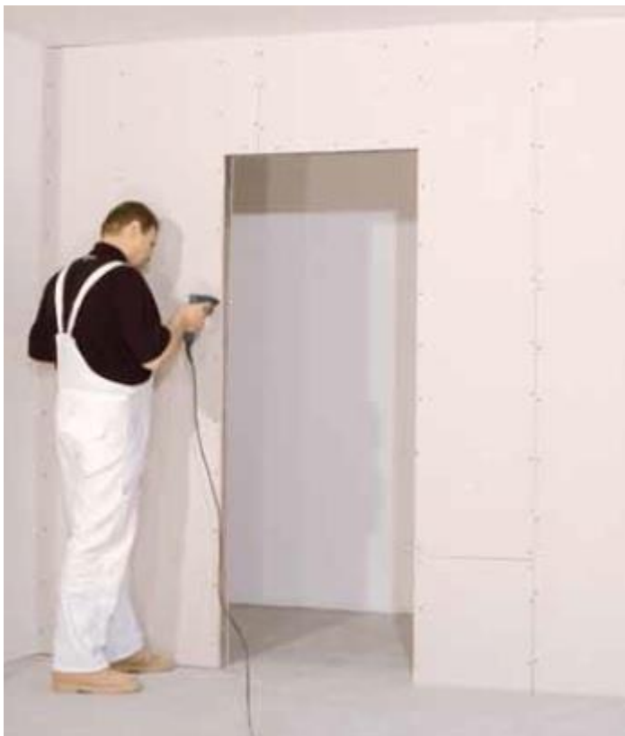
Obr. 15: Montáž opláštění – druhá strana příčky [7]
