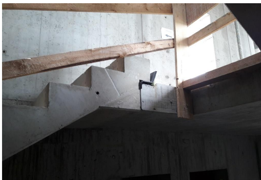
Obrázek 11- Uložení schodišťového ramene (pružné uložení)
